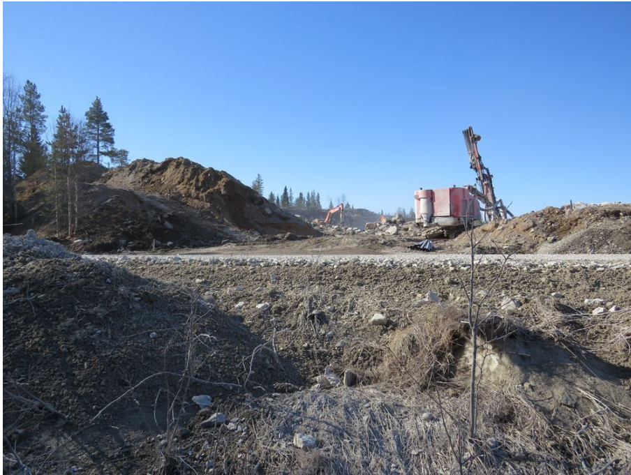
Hirsikankaantielle on ajettu paksut kerrokset soraa. Kuva lounaaseen louhokselle.
