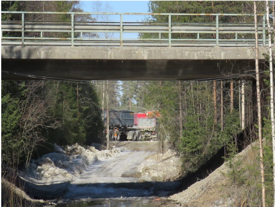
Jäämerentien alikulku, ulkoilu- ja moottorikelkkareitti, kuva luoteeseen.
