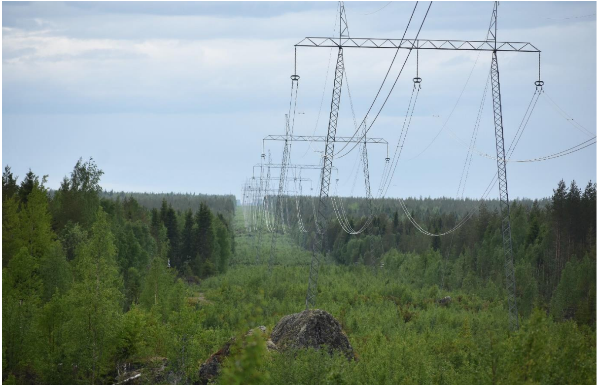
Kuva 28. Hankealueelle sijoittuu Fingridin Petäjäsoski-Letsi 400 kV voimajohto, jonka rinnalla hankkeen sähkönsiirtoa on tarkasteltu hankealueen ulkopuolella reitin länsiosassa. Nykyinen voimajohtokäytävä levenee Tervolan alueella kahden rinnakkaisen 400 kV voimajohdon alueeksi.
