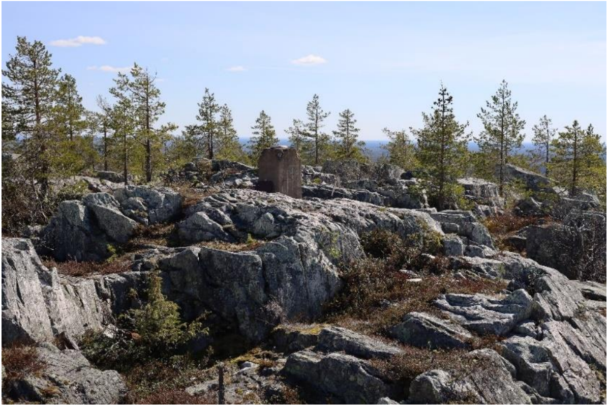
Kuva 3-13 Kaakamavaaran Tynnyrilaen päällä on myöhempiä kolmiomittauksia varten rakennetun kolmiomittaustornin betoniperustus.
