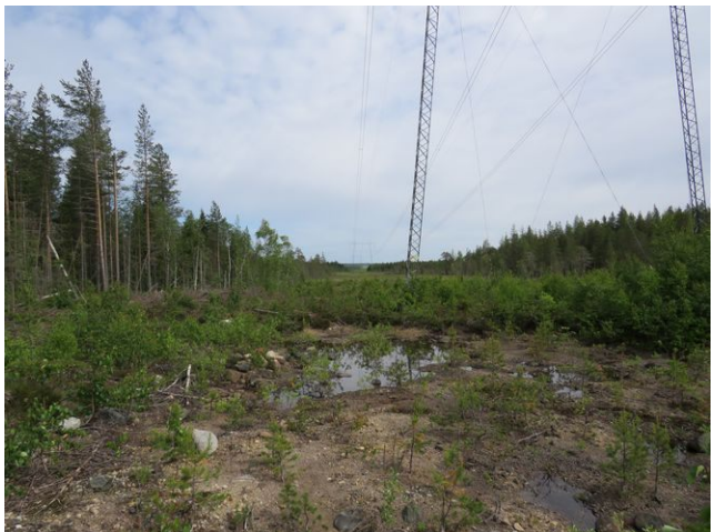
Kuva 26. Voimalinja Yhteisenlehdosta, kuvattu itään.
