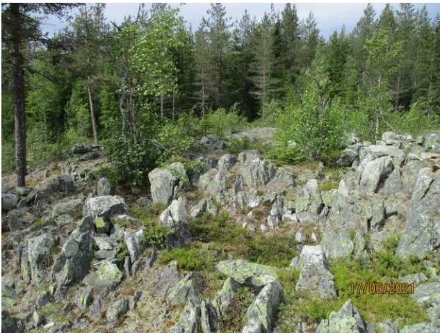
Kohde 1. Louhittua kalliota keskimmaisellä kallioalueella. Kuvattuna luoteeseen.
