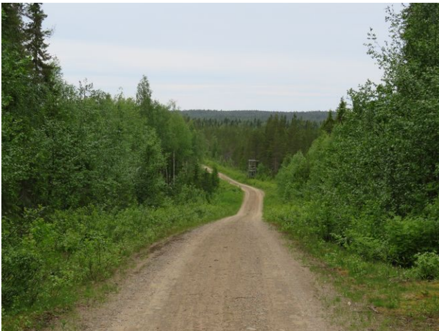
Kuva 29. Metsäautotie Trattilehdon kohdalla, kuvattu lounaaseen.
