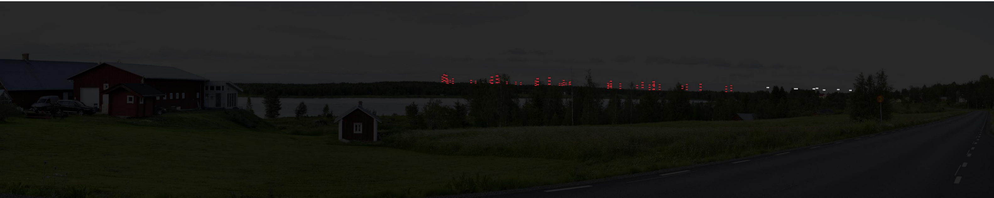
Kuva 103. Yöajan havainnekuva (iltahämärä) kuvauspisteestä 5. VE2. Kuvan keskellä näkyvät Karhakkamaan voimalat punaisilla lentoestevaloilla ja kuvan oikealla puolella Kitkiäisvaaran voimalat kirkkailla ja välkkyvillä lentoestevaloilla.
