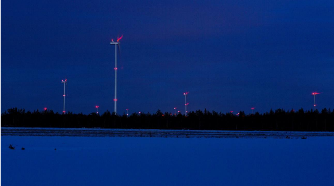
Kuva 13. Kiinteät punaiset lentoestevalot pimeällä.
