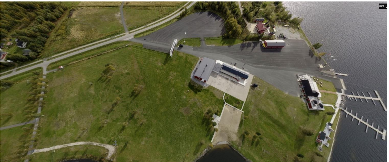
Kuva 3. Dronekuvaa suunnittelualueesta. Kuvaote toranda.fi -kotisivuilta.
