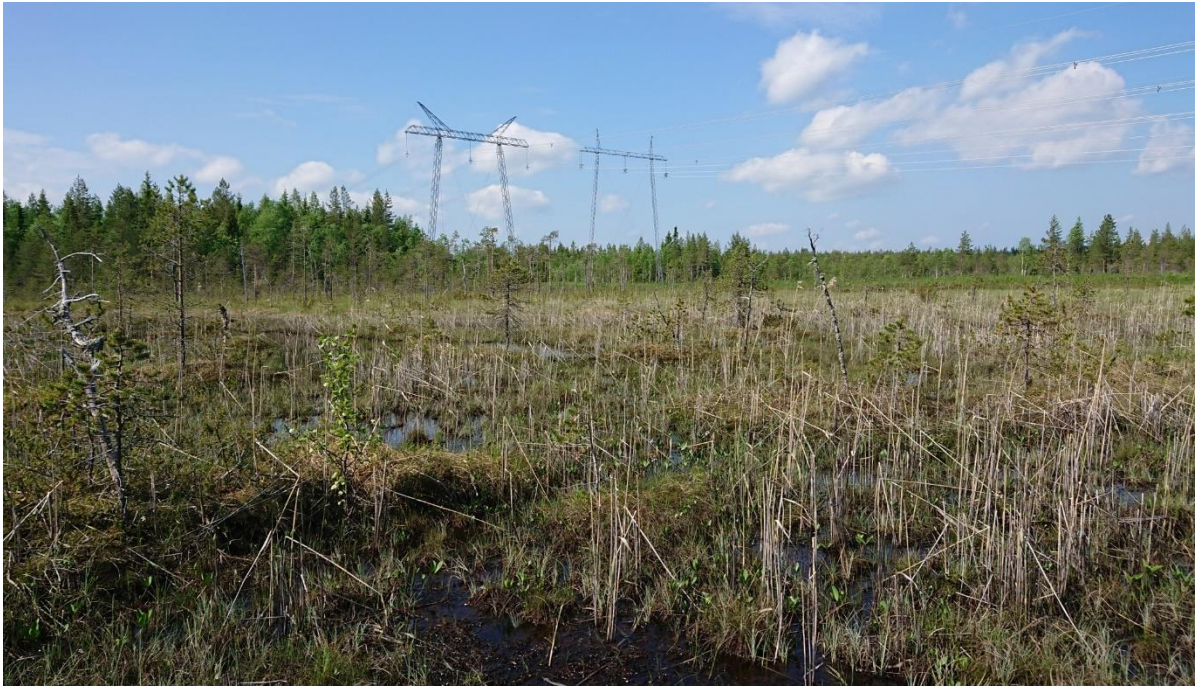
Kuva 36. Sähkösiirtoreitin rimpilettoa ja lettorämettä Tervolassa, Pukinselkä W.
