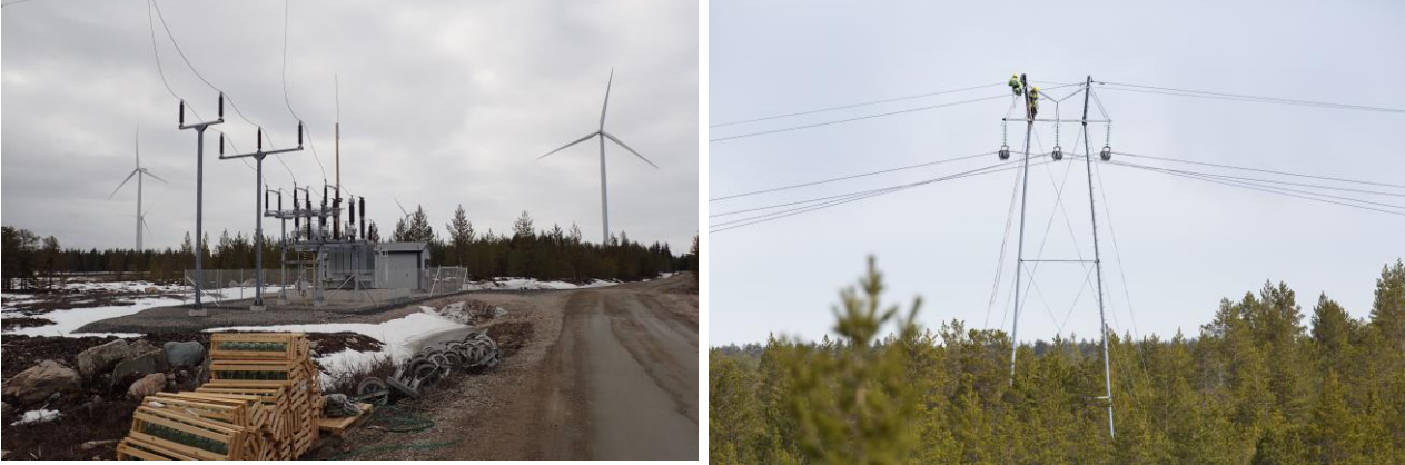
Kuva 26. Sähköaseman ja voimajohdon rakentamista. (Kuvat: FCG)
