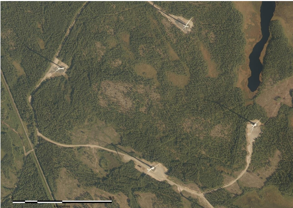
Kuva 11. Ilmakuvassa näkyy toiminnassa olevia tuulivoimaloita. Tuulivoimaloita varten on rakennettu huoltotiet ja nostokentät. Tuulivoimaloiden ympäristössä ja välialueilla aikaisempi maankäyttö on säilynyt ennallaan.
