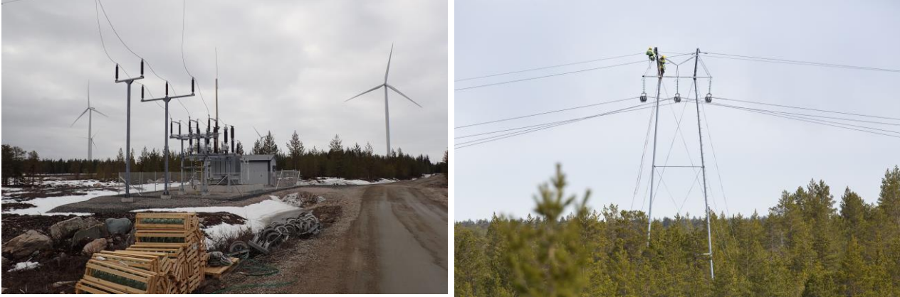
Kuva 26. Sähköaseman ja voimajohdon rakentamista. (Kuvat: FCG)
