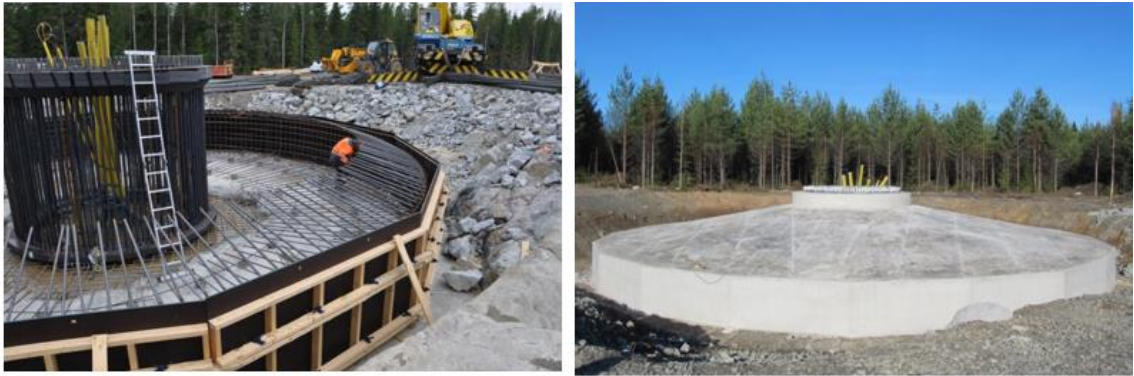
Kuva 24. Tuulivoimalan perustusten rakentamista. (Kuvat: FCG)
