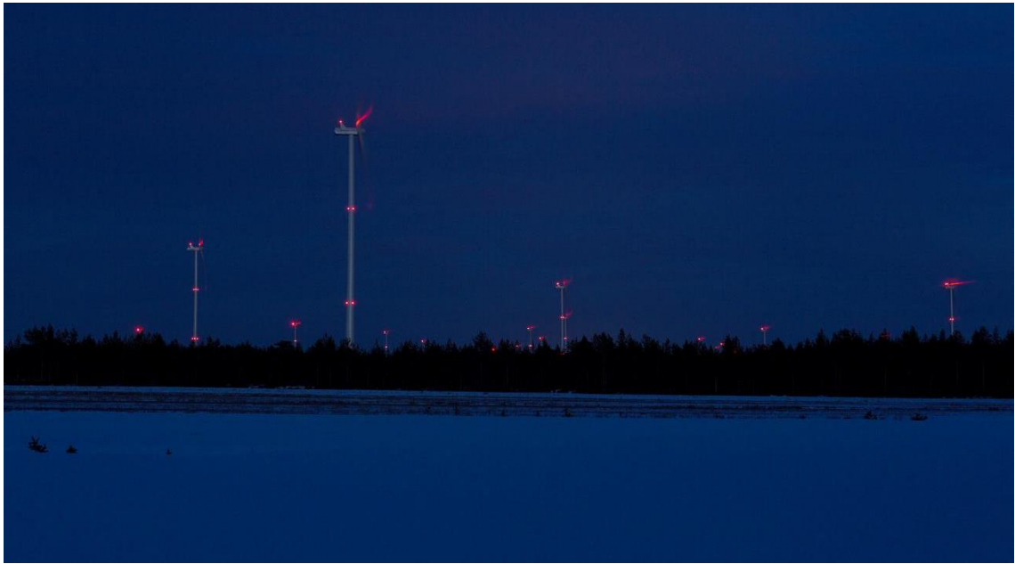
Kuva 14. Kiinteät punaiset lentoestevalot. (Kuva: Ville Suorsa, FCG)
