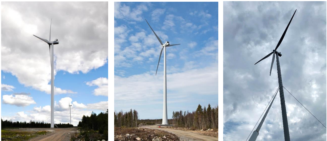
Kuva 12. Vasemmalla on esimerkki teräslieriötornista, keskellä hybriditornista ja oikealla harustetusta tornista. (Kuvat: FCG sekä Jarkko Finnilä, Carelin)
