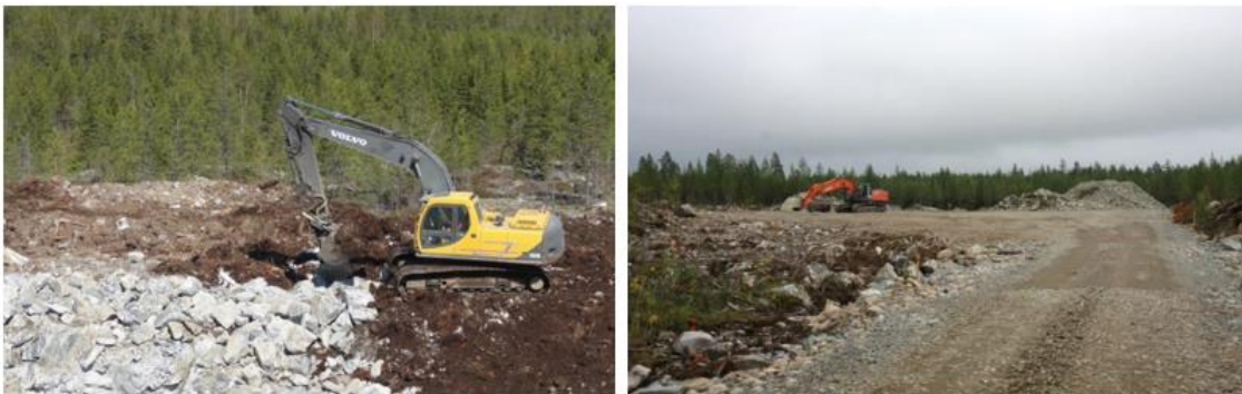
Kuva 22. Tuulivoimapuiston rakentaminen alkaa huoltoteiden ja pystytysalueiden rakentamisella (kuvat: FCG).
