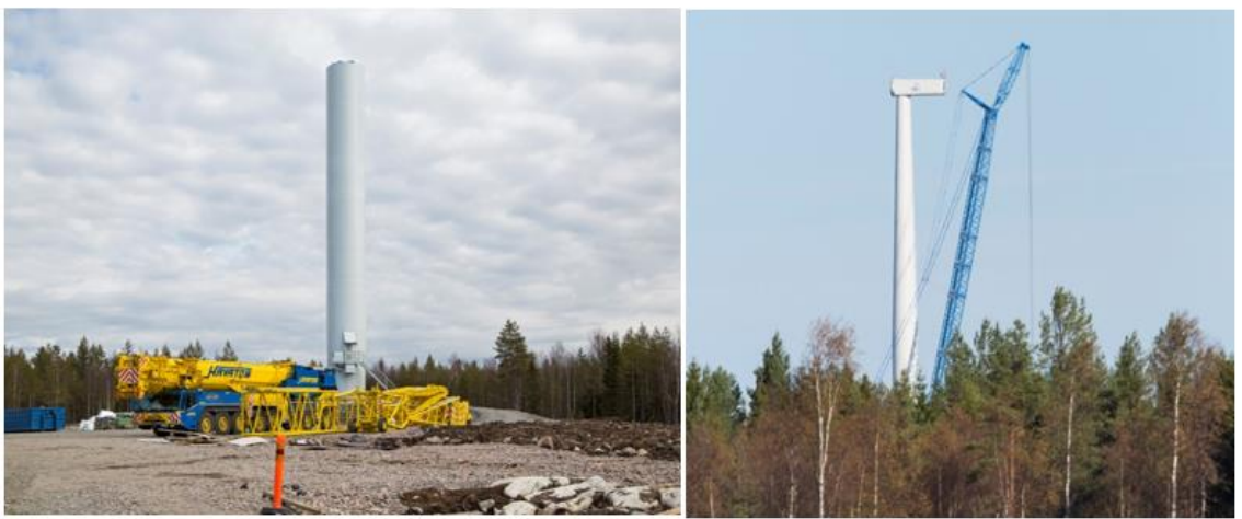
Kuva 25. Tuulivoimalan kokoamista. (Kuvat: FCG)
