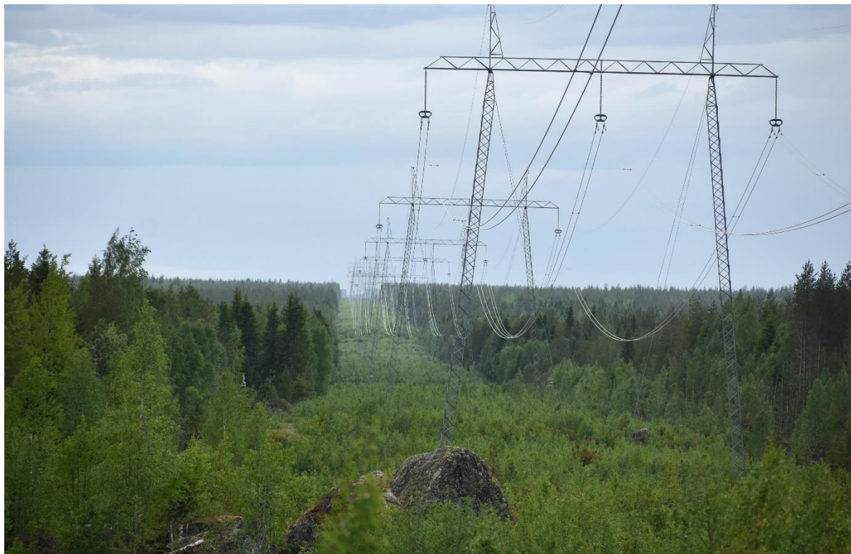
Kuva 34. Hankealueelle sijoittuu Fingridin Petäjäsoski-Letsi 400 kV voimajohto, jonka rinnalla hankkeen sähkönsiirtoa on tarkasteltu hankealueen ulkopuolella reitin länsiosassa. Nykyinen voimajohtokäytävä levenee Tervolan alueella kahden rinnakkaisen 400 kV voimajohton alueeksi.
