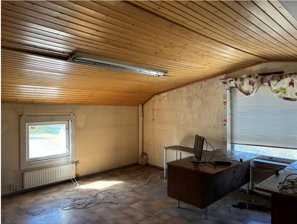
Kattorakenne myödanntyt, tilan korkeus matala.
