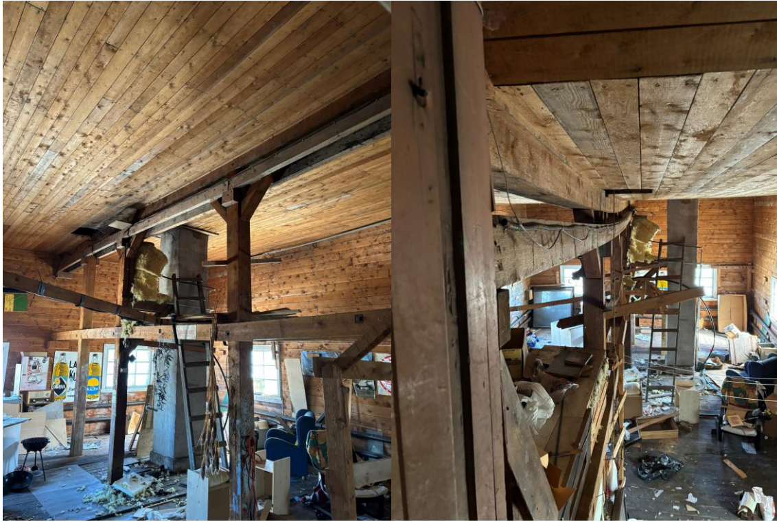
Katon kantava runko pettänyt ja taipunut notkolle.
