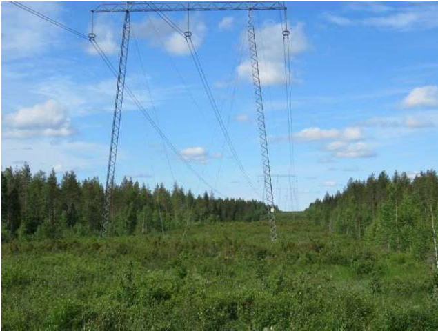
Kuva 58. Linjaus Santalammen eteläpuolella.
