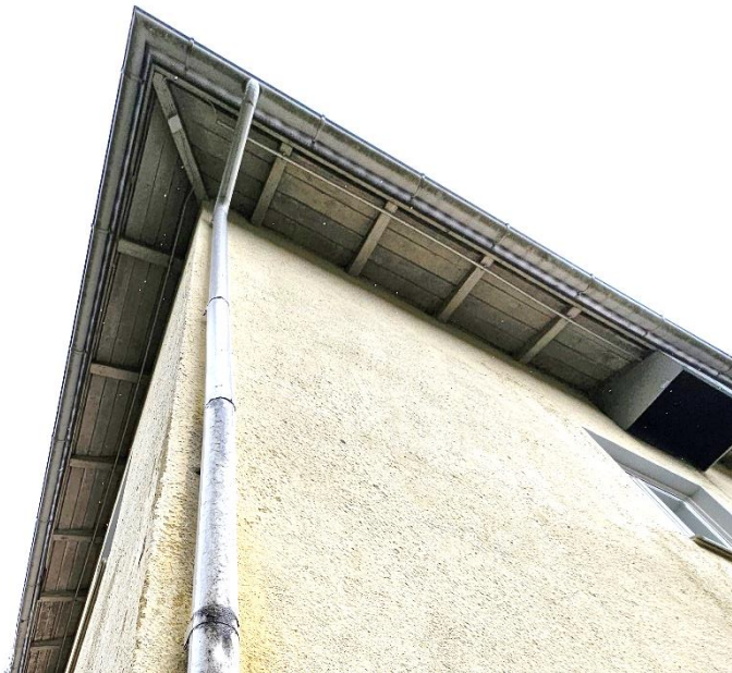
Kuva 33, räystäsrakennetta alta kuvattuna
