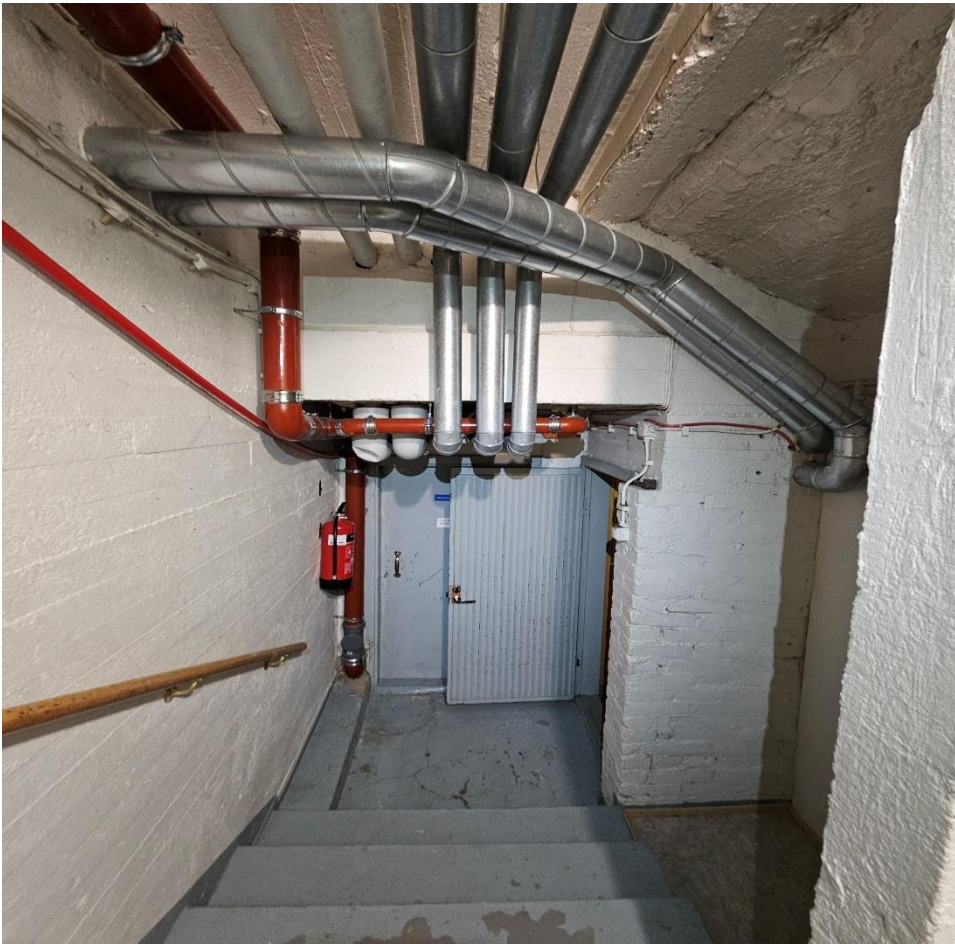
Kuva 57, kellarissa uusittu viemäriinja valurautaputkistolla
