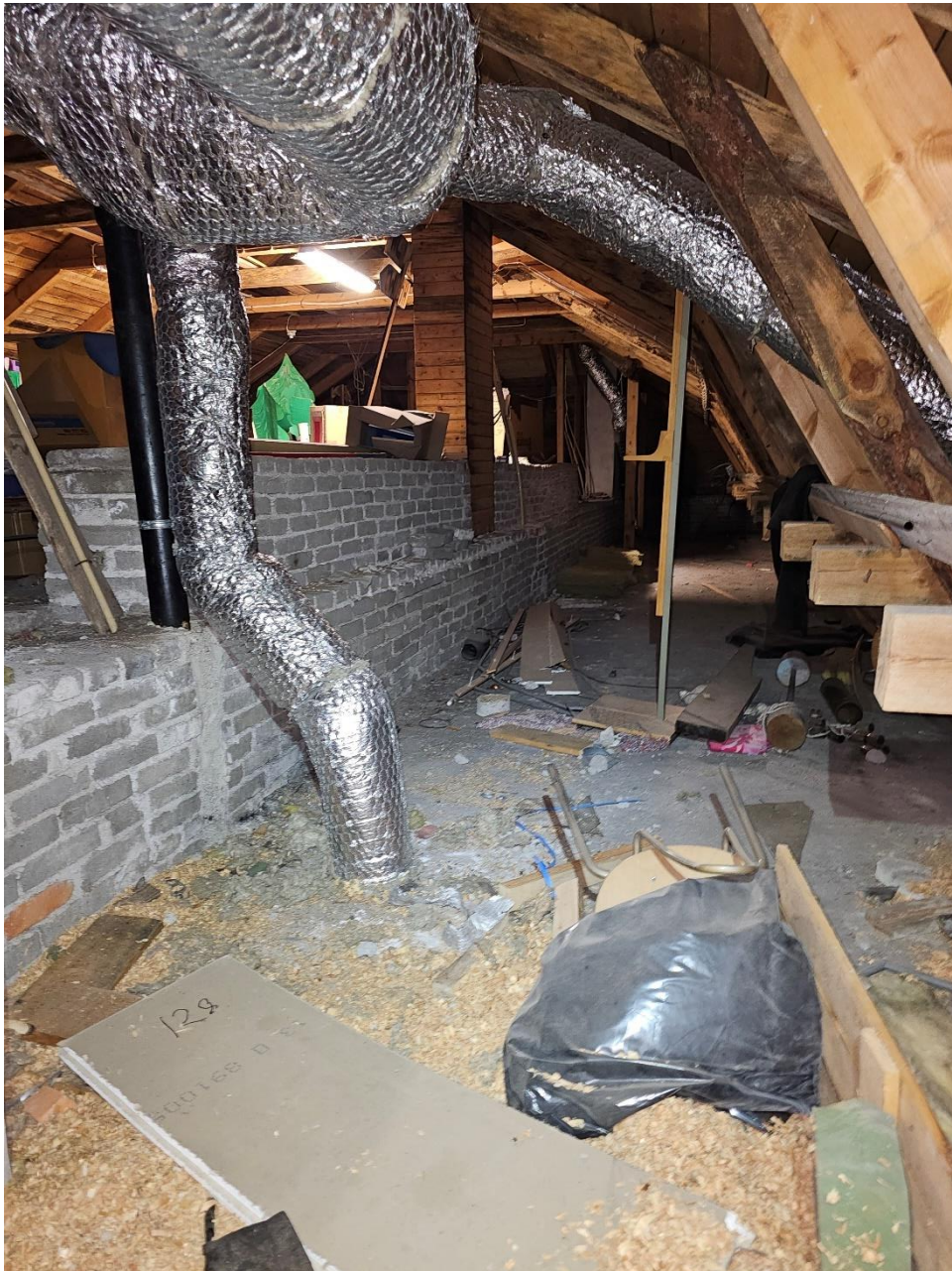
Kuva 16, muurattuja rakenteita ullakon porrastuksella
