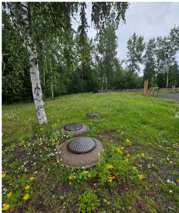
Kuva 59, suodatuskentän kaivoja, kuvassa perällä edellisen kuvan putket Viemäritä on saneerattu, alkuperäiset linjat on pinnoitettu. Kuntoluokka 3. Muoviviemäreiden tekninen käyttöikä on 50 vuotta.
