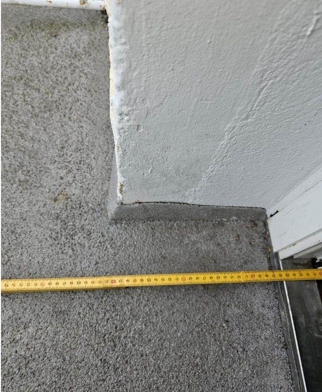
Kuva 13, ulkoseinä välitasanteen parvekkeen tasolla n. 60 cm
