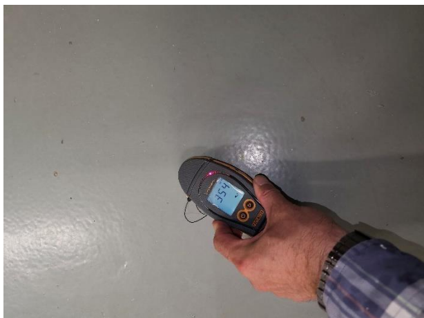
Kuva 9, pintakosteus koholla, maalattua lattiaa puutyötilassa
