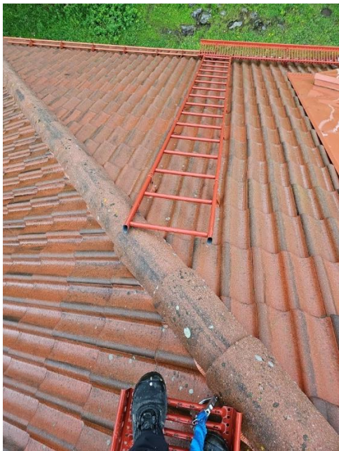
Kuva 38, lapetikkaan ja kulkusillan rajalla on hankala siirtymä
