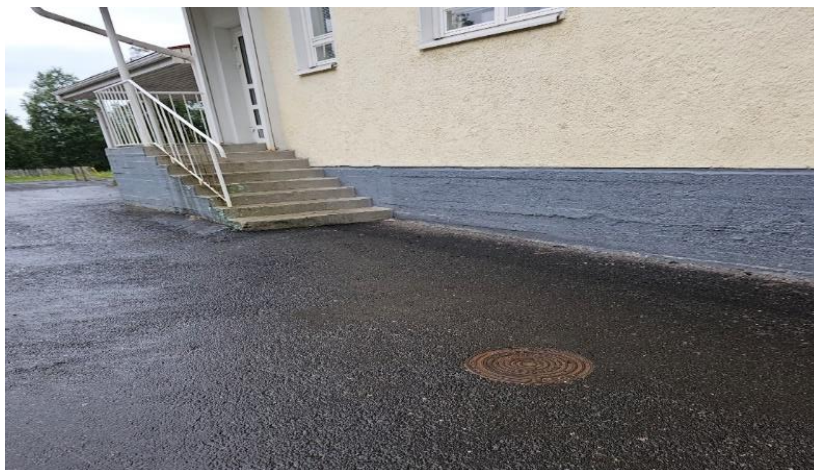
Kuva 8, sokkelia ja porrasta
