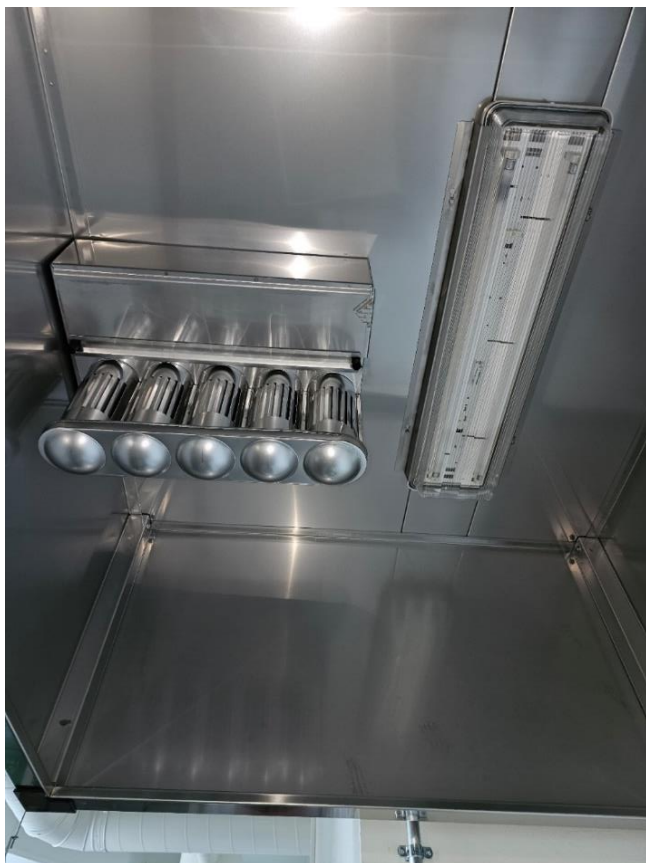
Kuva 68, keittiön huuva sisäpuolelta, erittäin hyväkuntoinen
