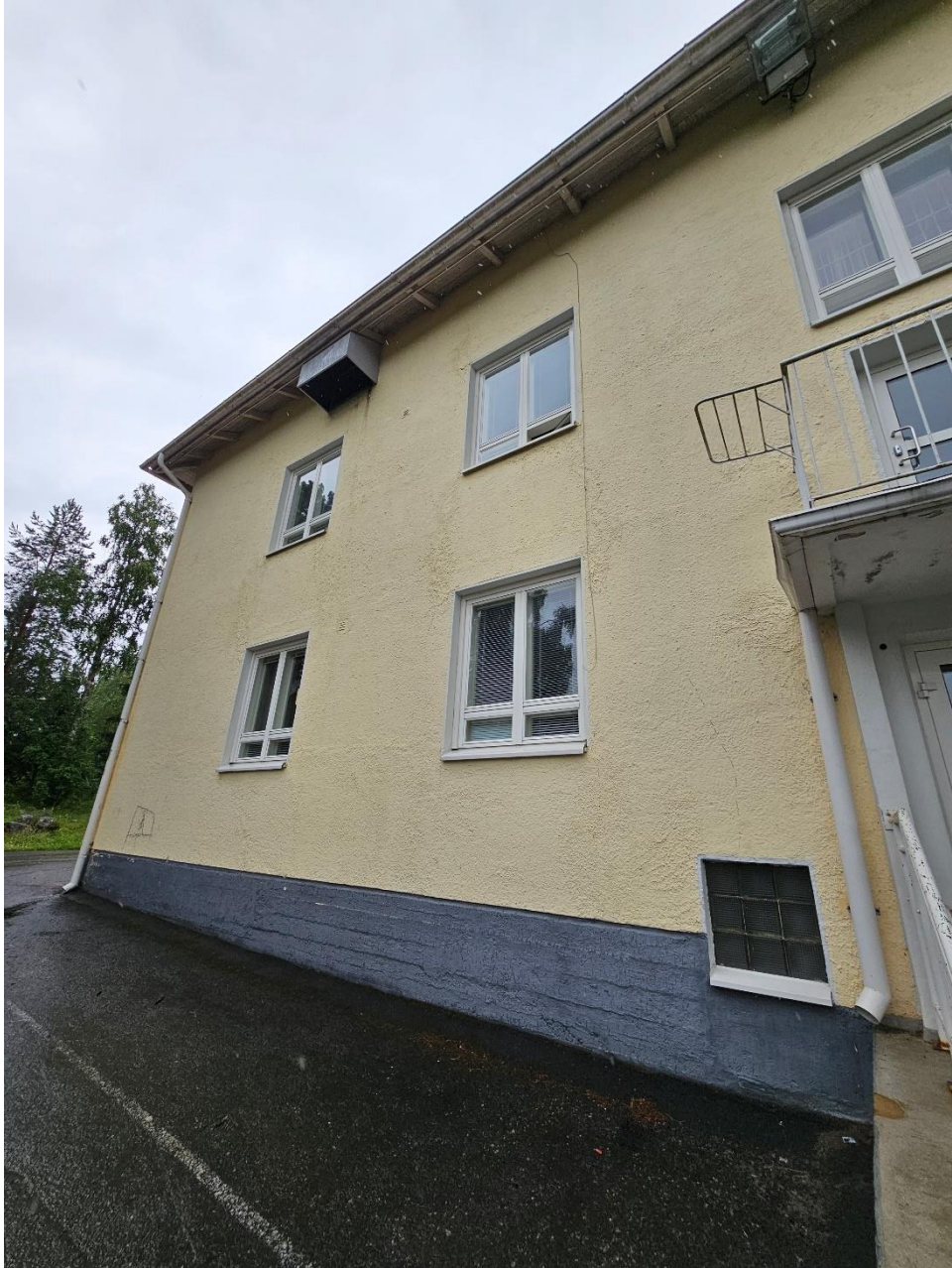
Kuva 21, julkisivussa korjattuja kohtia
