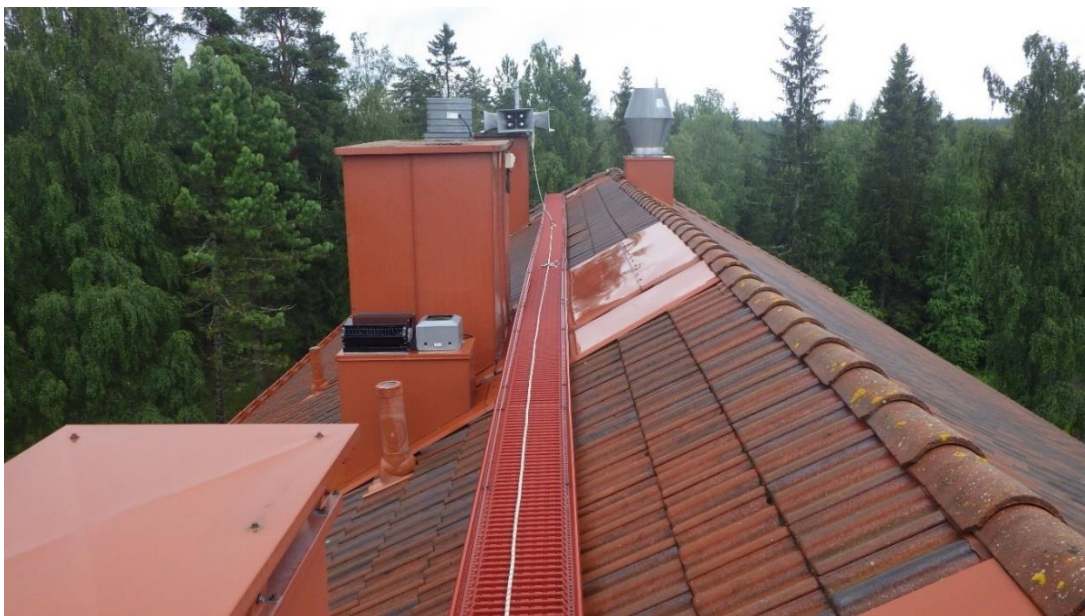
Kuva 39, yleiskuva katolta, varusteita ja piippujen pellityksiä, suhteellisen uusia
