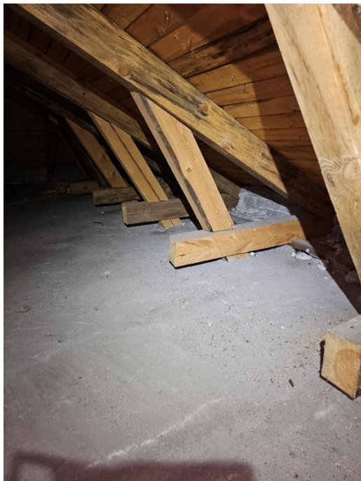
Kuva 31, yleiskuva kattotuolirakenteista ja palopermantoa
