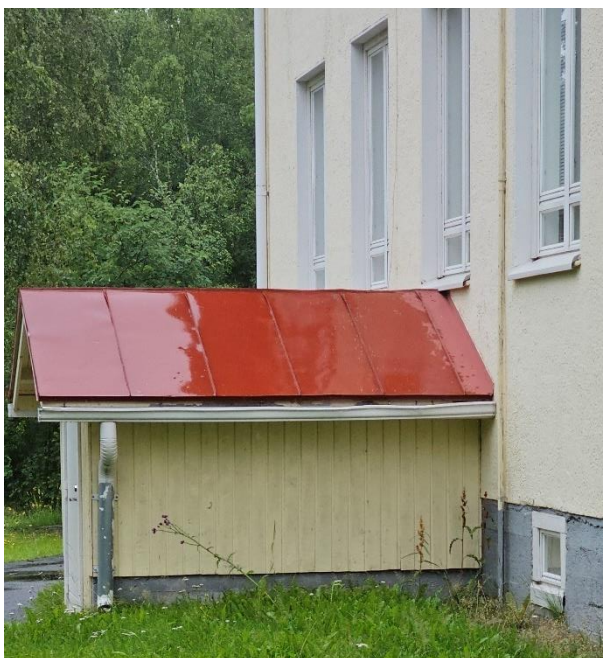
Kuva 36, kuistien katokset ja kellarin portaikkojen lyhdyt peltikatteella
