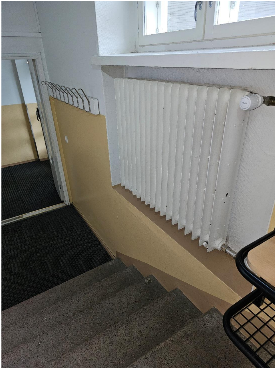
Kuva 53, seinäasenteinen radiaattorimalli
