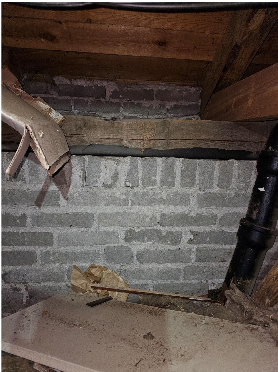
Kuva 11, ullakolla ulkoseinän sisäpuolen muuraus on sementtitiilellä
