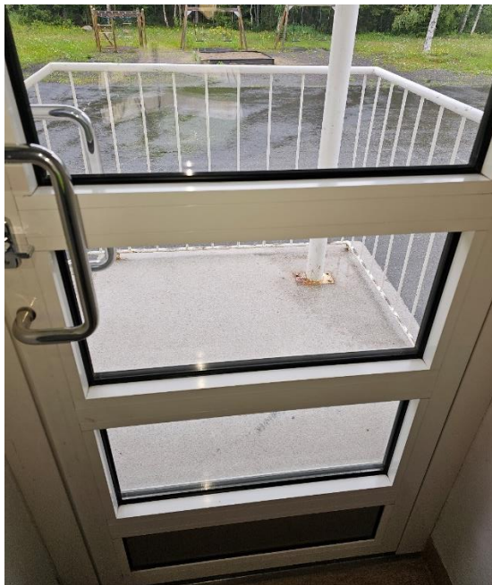
Kuva 24, toisen päädyn ovea sisältä, ovet hyväkuntoisia
