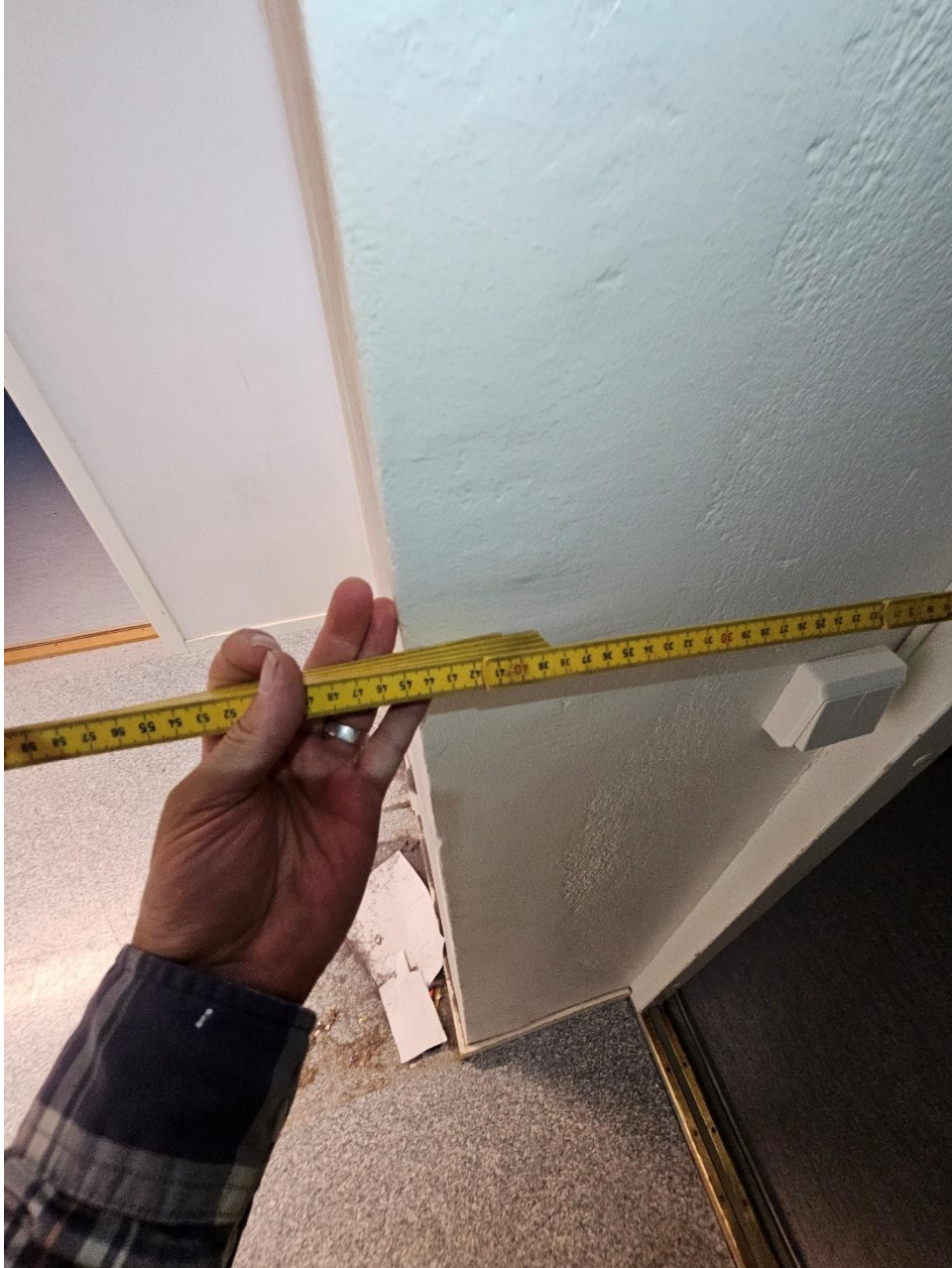
Kuva 12, rakennuksen pituussuuntainen seinä n. 45 cm
