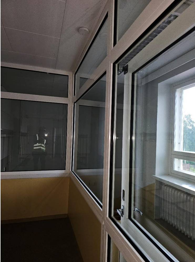
Kuva 42, ylätasanteen ja portaan välinen lasiseinä
