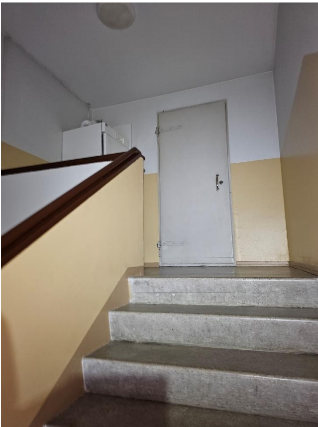
Kuva 44, ullakon ovi on vanha peltinen palo-ovi
