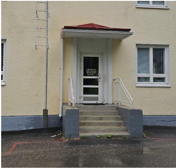
Kuva 29, toisen pään katoksella ei ole pilareita
