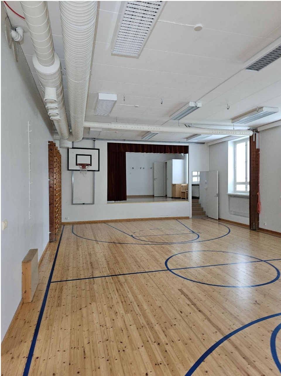
Kuva 67, salin ilmanvaihtolaitteita
