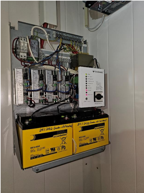
Kuva 74, hätäpoistumisvalaistuksen akut
