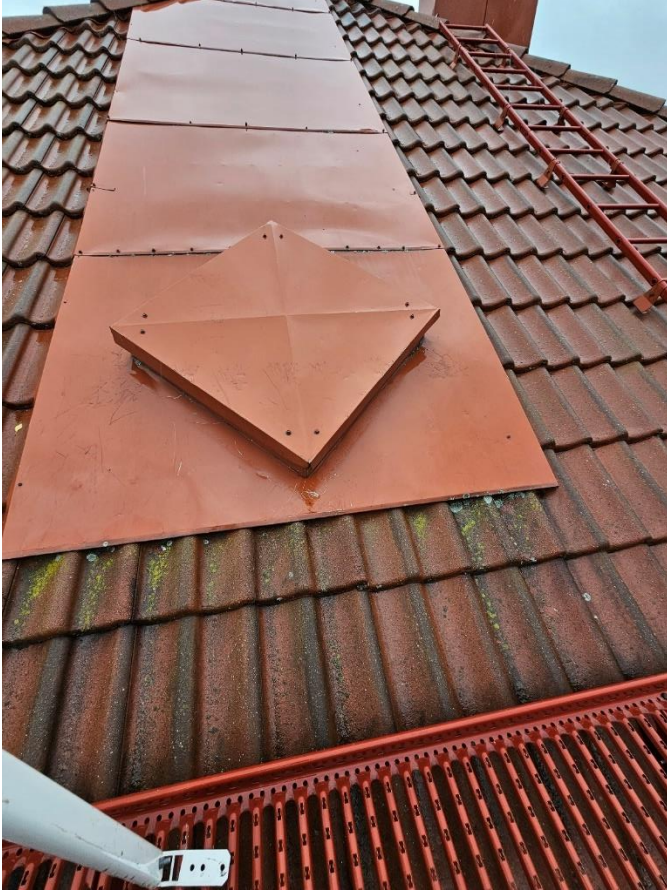
Kuva 41, kattoluukku
