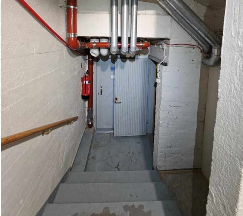
Kuva 43, kellarissa alkuperäisiä puuovia ja peltipalo-ovia
