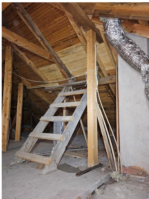
Kuva 32, puurakennetta on uusittu paikallisesti, todennäköisesti vesikattosaneerauksen yhteydessä
