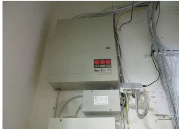
Kuva 168. Murtojärjestelmän keskusyksikkölaiteita.
