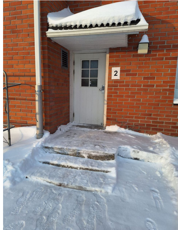
Kuva 35. Puurakenteinen ulko-ovi
