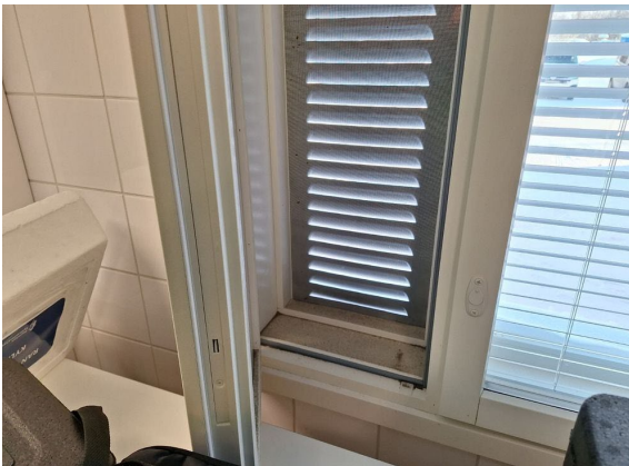
Kuva 28. Uusittu ikkuna tuuletusluukku avattuna.
