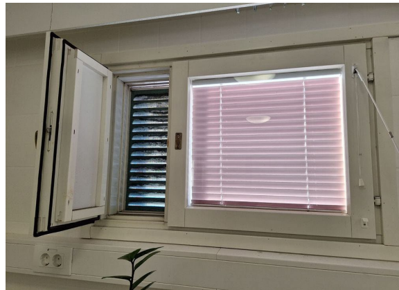
Kuva 29. Alkuperäinen ikkuna tuuletusluukkusavattuna.
