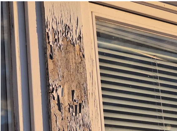
Kuva 22. Hilseilyä ja alkavaa lahovikaa ikkunoiden puuosissa.
