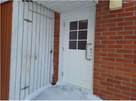
Kuva 34. Uusittu ulko-ovi ja lautarakenteinen varastotilan ovi.
