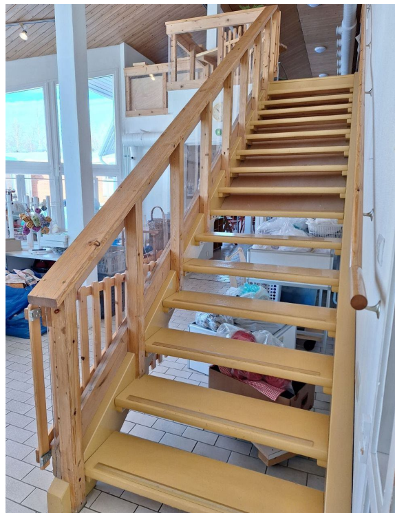
Kuva 54. Ruokalan toisen kerroksen portaat
