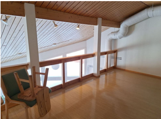
Kuva 10. Pilari- ja puupalkkirakenteita.
