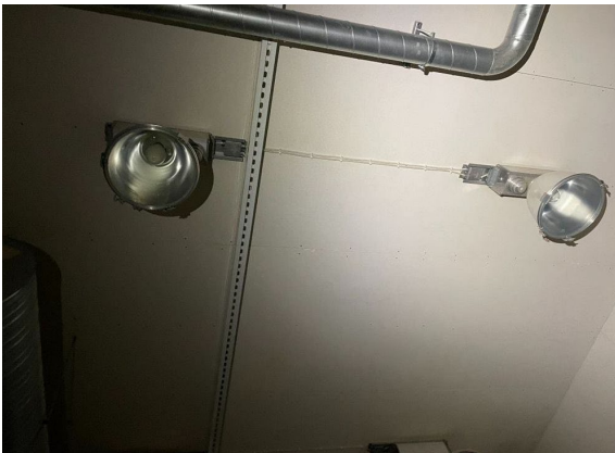
Kuva 142. Maalaamon purkauslamppuvalaisimia.
