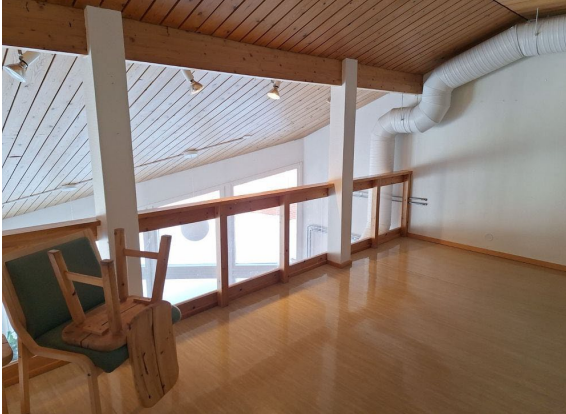
Kuva 55. Ruokalan toisen kerroksen kaide.
