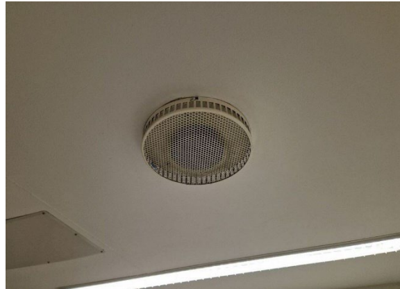
Kuva 106. Tuloilman päätelaite.
