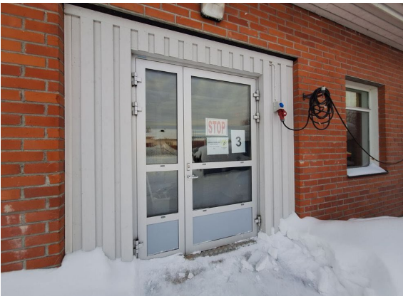
Kuva 36. Alumiinirakenteinen ulko-ovi
