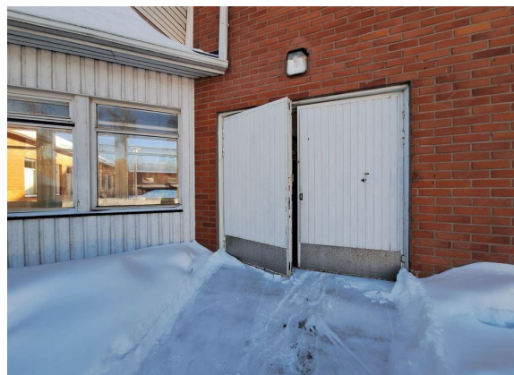
Kuva 43. Hallin ovet ulkoa päin.
