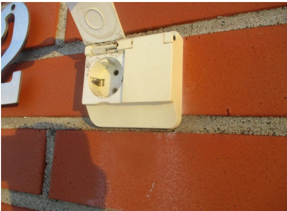
Kuva 130. Ulkopistorasioita.
