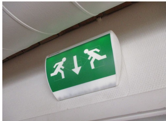
Kuva 150. Uudempia poistumistievalaisimia.
