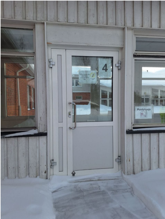
Kuva 38. Alumiini ulko-ovi
