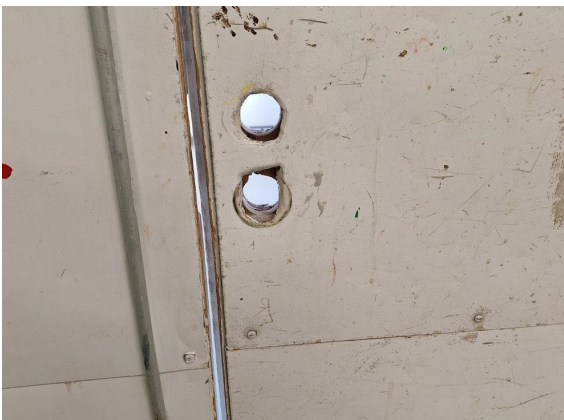
Kuva 40. Hallin ovet ovat vetoisia.
