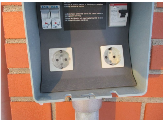
Kuva 134. Autolämmityskoteloita.
