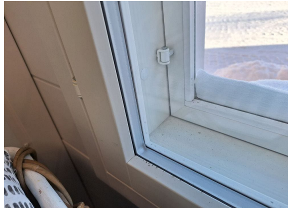
Kuva 27. Uusittu ikkuna sisäpuolelta
