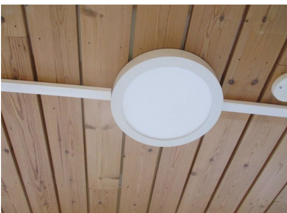
Kuva 138. Uusittuja LED-valaisimia.
