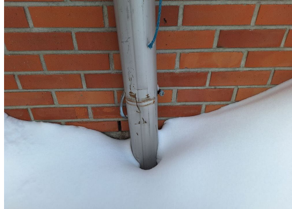
Kuva 13. Julkisivujen alaosat olivat lumipeitteiset.
