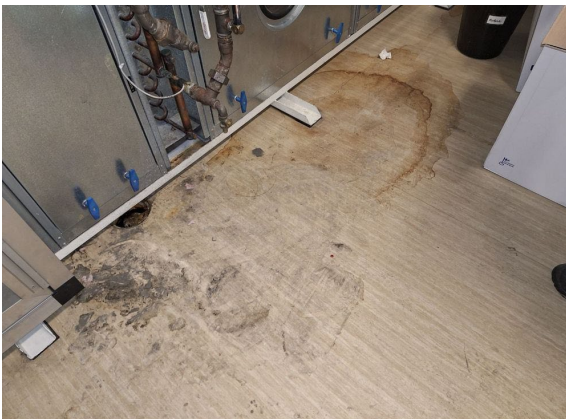
Kuva 69. IV-konehuoneen lattian muovimatto
