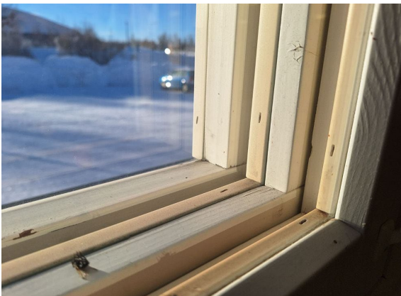
Kuva 30. Alkuperäinen ikkuna sisältä.
