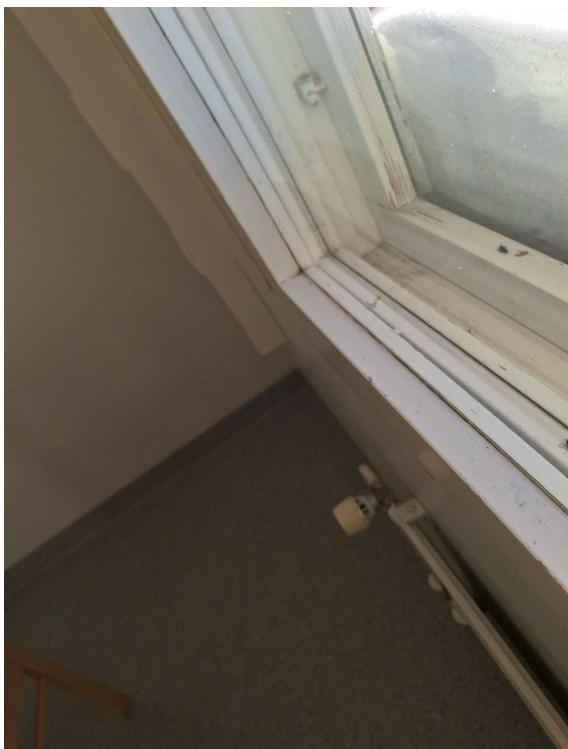
Kuva 32. Alkuperäinen ikkuna sisältä.
