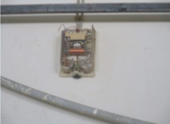
Kuva 166. Puutyötilan kumistin kansi irti, huoltotoimi asennus, mikäli tarvetta tai poistaminen.
