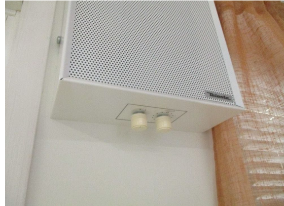
Kuva 159. Säädettävä kaiutin.
