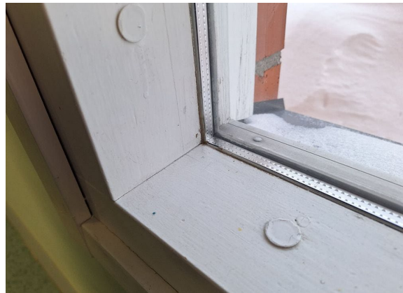
Kuva 23. Alkuperäinen ikkuna sisäpuolelta.
