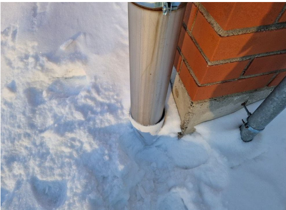
Kuva 5. Syöksytorvien vesi on ohjattu suoraan sadevesijärjestelmään.
