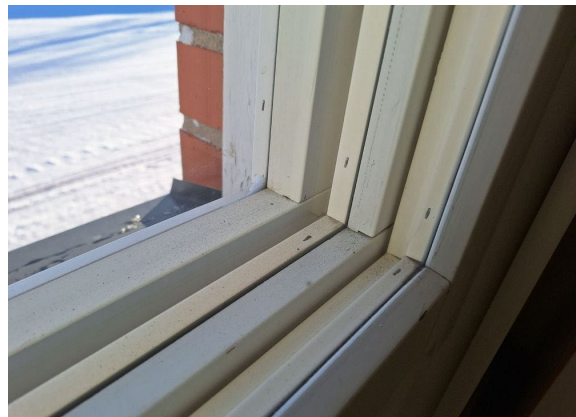
Kuva 31. Alkuperäinen ikkuna sisältä.
