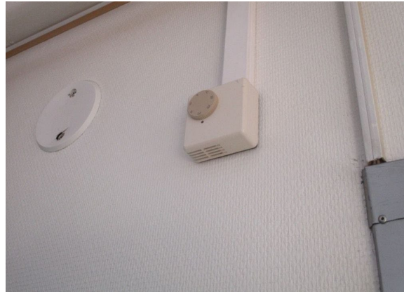
Kuva 181. KIK-laitteiston termostaatti tuulikaapissa.
