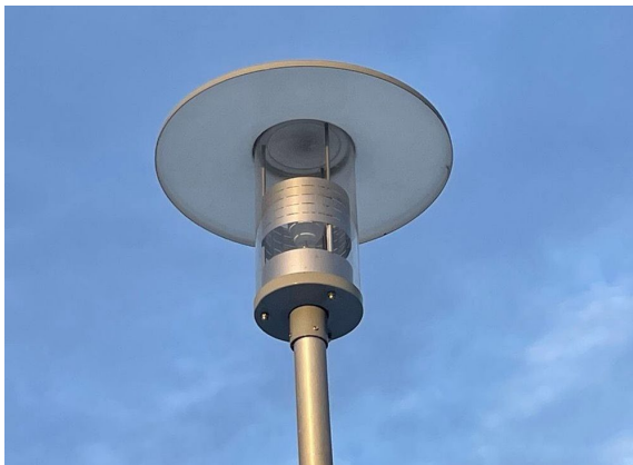
Kuva 144. Purkauslamppu pylväsvalaisimia.
