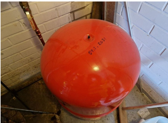
Kuva 77. Lämmityksen paisuntasäiliö.
