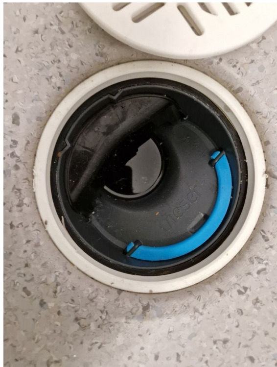
Kuva 92. Uusittu lattiakaivo.
