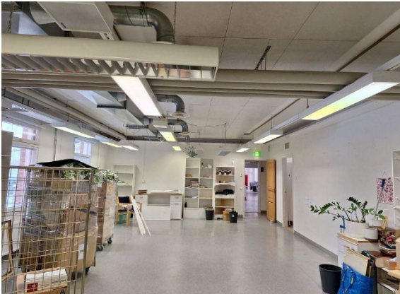
Kuva 57. Tekstiliosaston työtilan tilapintoja
