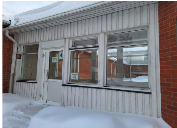
Kuva 15. Julkisivujen alaosat olivat lumipeitteiset.
