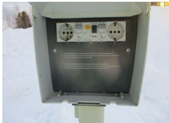
Kuva 135. Uusittuja autolämmityskoteloita, 2013.
