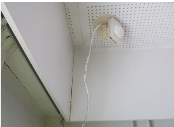
Kuva 171. Ryhmätilassa IR-tunnistin johto irti.
