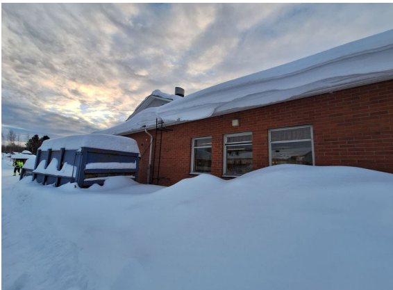
Kuva 14. Julkisivujen alaosat olivat lumipeitteiset.
