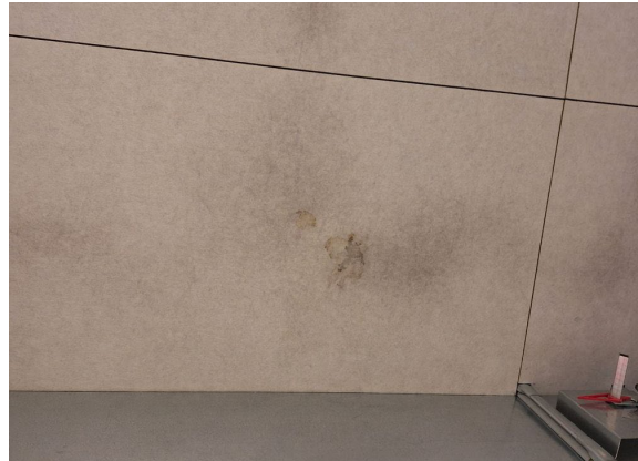
Kuva 58. Tummumia ääneneristyslevytyksessä.
