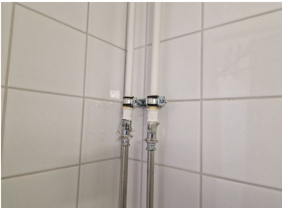
Kuva 79. Alkuperäistä ja uusittua lämpöjohtoa WC-tilassa
