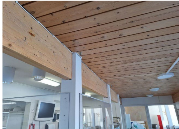
Kuva 9. Pilari- ja puupalkkirakenteita.
