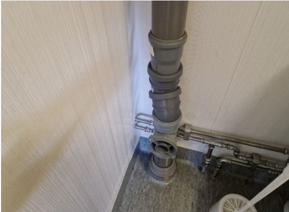
Kuva 86. Muoviviemäriä suihkutilassa.
