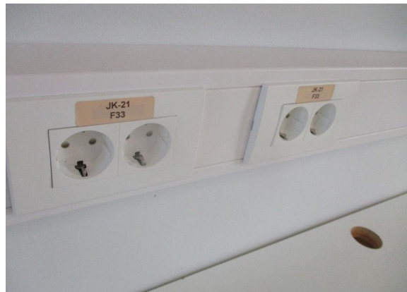
Kuva 113. Kaapelikouruasennusta.
