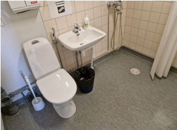
Kuva 95. Uusittuja vesikalusteita.
