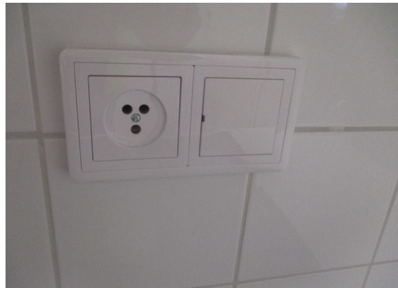
Kuva 165. Uusittuja puhelinrasioita talouskeittiössä.
