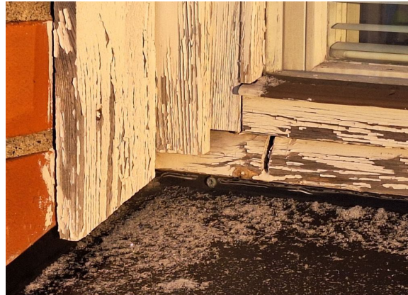
Kuva 21. Hilseilyä ja alkavaa lahovikaa ikkunoiden puuosissa.
