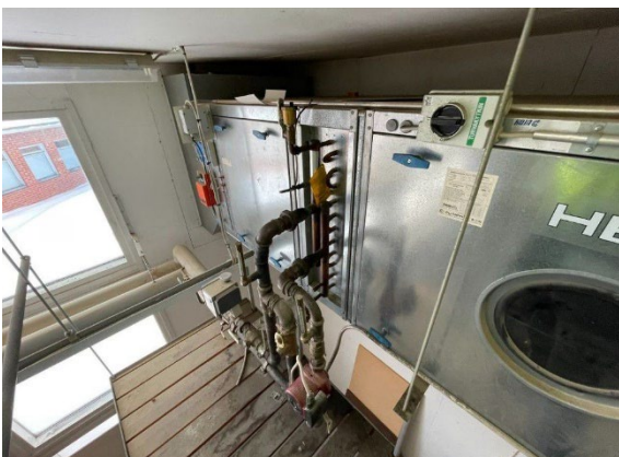
Kuva 124. IV-koje sähköistyksiä (1993).
