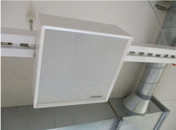
Kuva 158. Kaiuttimia ripustinkiskossa.
