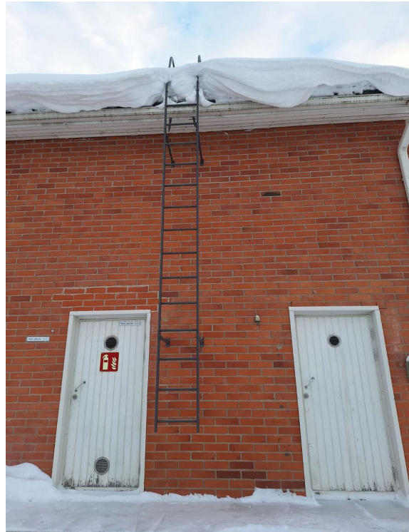
Kuva 39. Teknisen tilan ovia
