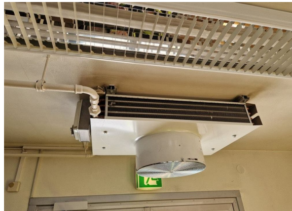
Kuva 85. Eteisen kiertoilmakoje ABB (vv. 1994).
