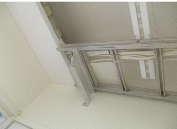
Kuva 112. Hylly- ja valaisinripustinkisko asennusta.
