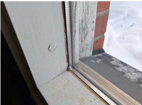
Kuva 24. Alkuperäinen ikkuna sisäpuolelta.
