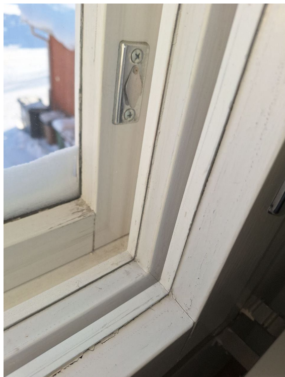
Kuva 33. Alkuperäinen ikkuna sisältä.
