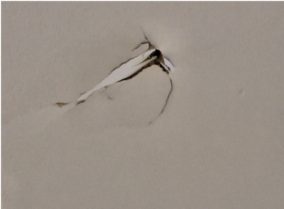
Kuva 65. Sisäpinnoissa on mineraalivillakuitulähteitä
