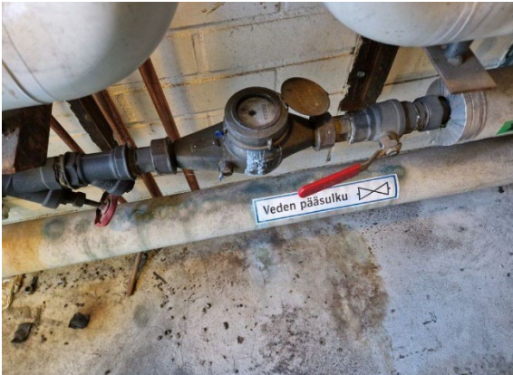
Kuva 87. Päävesimittari.
