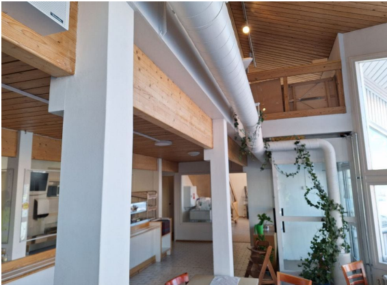
Kuva 8. Pilari- ja puupalkkirakenteita.
