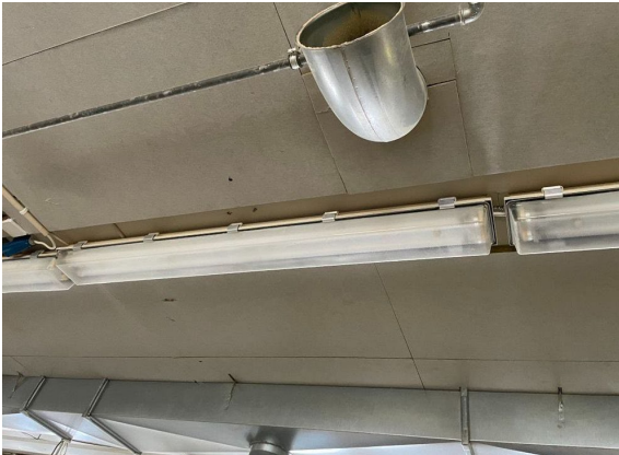
Kuva 140. Puutyöhuoneen loistevalaisimia.
