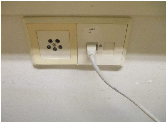
Kuva 164. Antenni ja puhelinrasia näkymää.
