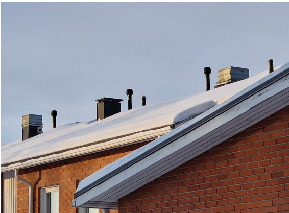
Kuva 100. Huippumureita katolla.
