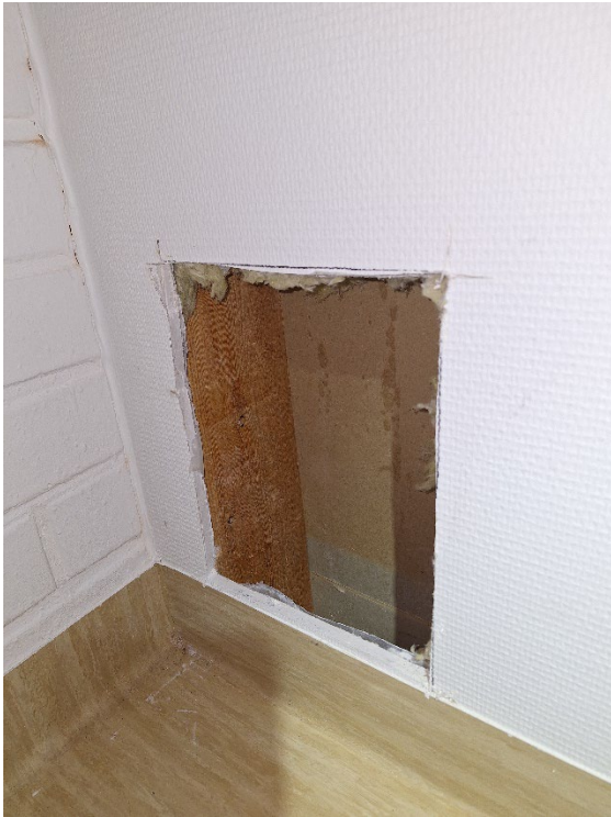
Kuva 8. Tilan 107 rakenneavauspiste Ra 2.
