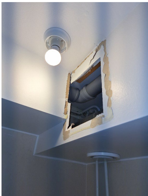
Kuva 20. WC:n 112 kotelointi tarkastusluukkuineen.
