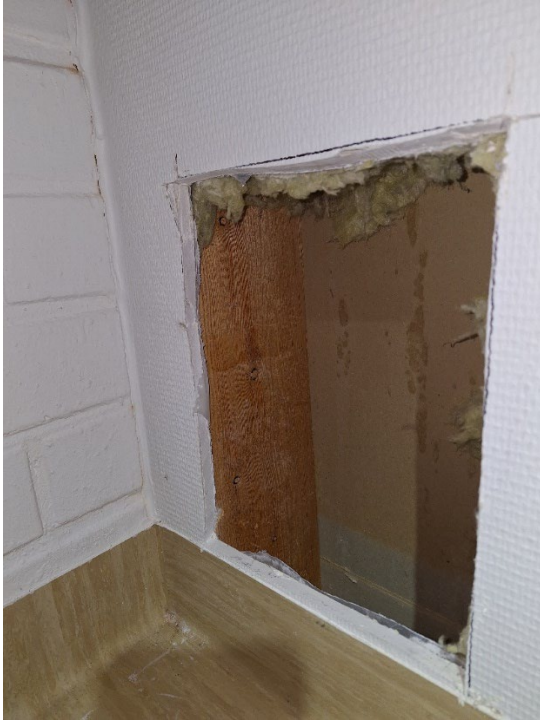
Kuva 3. Rakenneavauspiste ulkoseinään tilassa 101.
