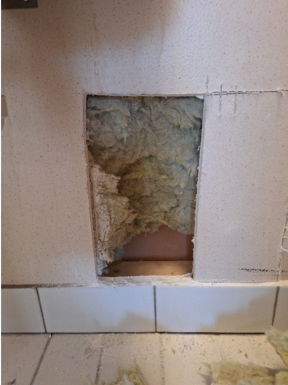
Kuva 14. Tilan 110 rakenneavauspiste Ra 5.
