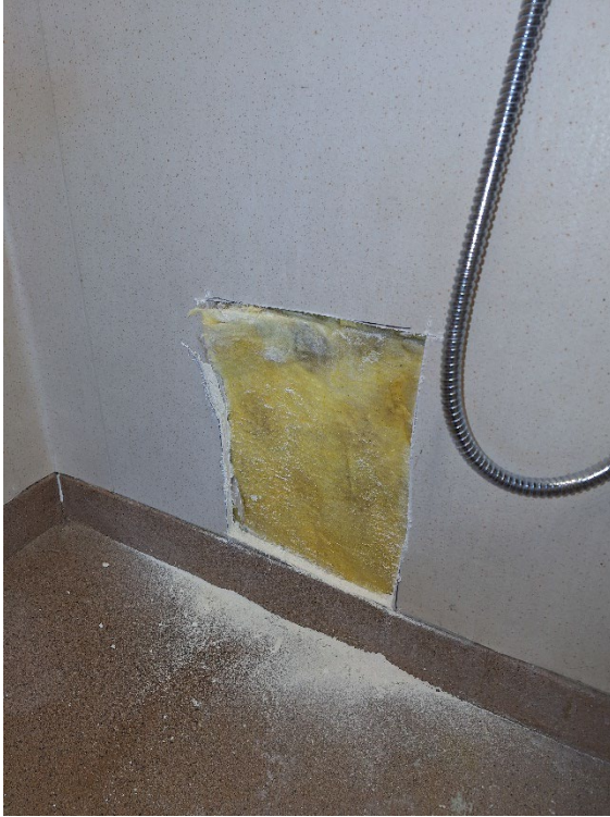
Kuva 10. Tilan 110 rakenneavauspiste Ra 3.
