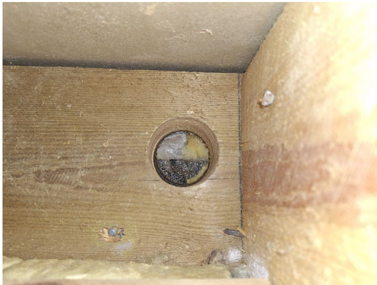
Kuva 7. Tilan 101 rakenneavauspiste Ra1 seinän sisältä.
