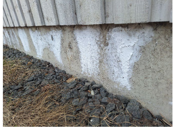
Kuva 6. Kosteusrasitusjälkiä sokkelissa.
