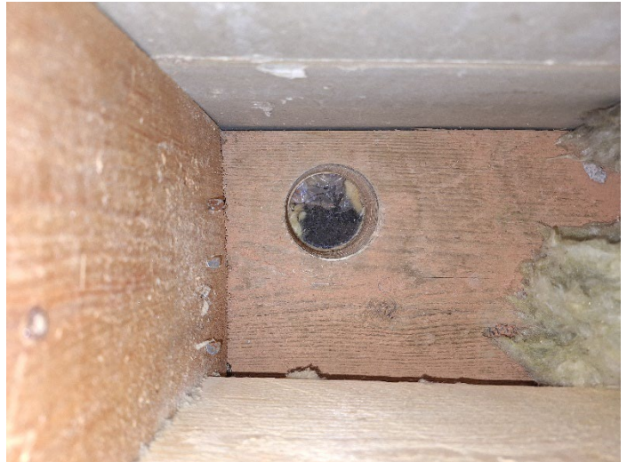
Kuva 9. Tilan 107 rakenneavauspiste Ra 2 seinän sisältä.
