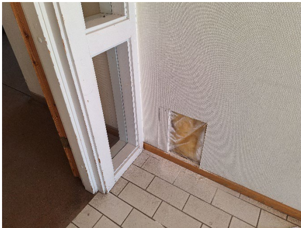
Kuva 16. Tilan 113 rakenneavauspiste Ra 5.
