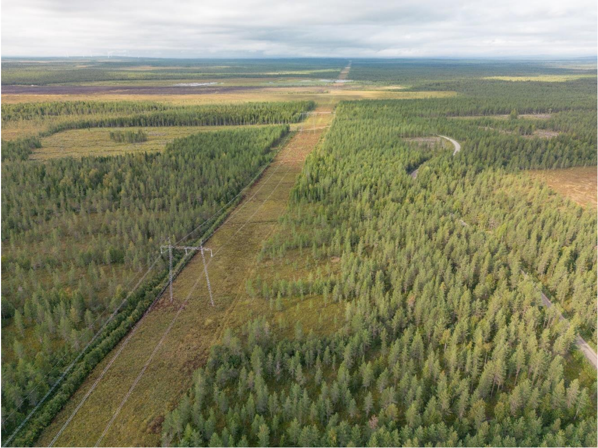
Kuva 4.11. Valokuva Petäjaskoski-Letsi 400 kV:n voimajohdosta (Kuva: Myrsky Energia Oy/Ville Suorsa).
