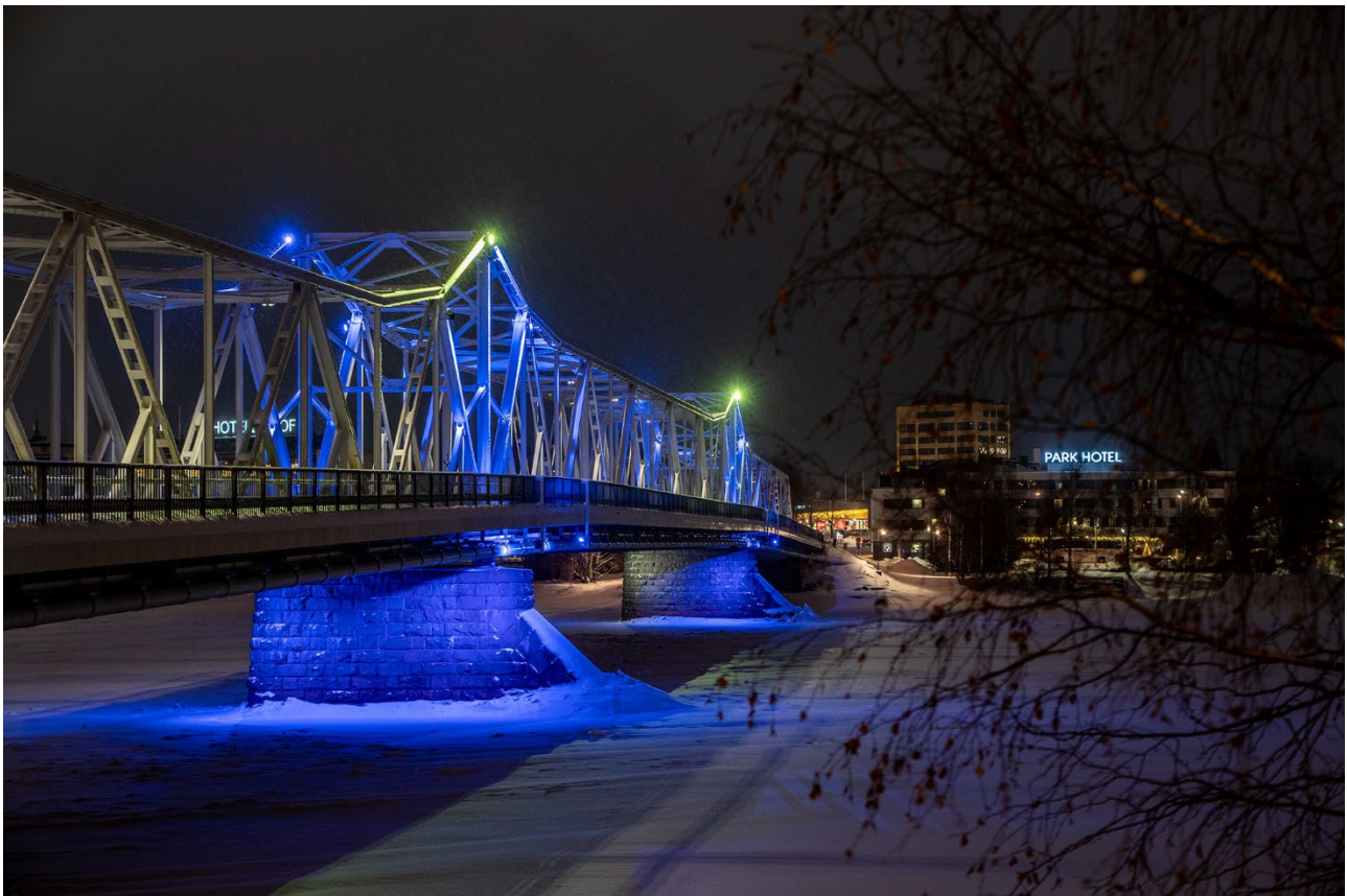
Kuva: Tornion kaupunki
