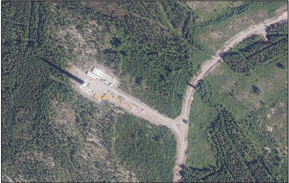
Kuva 7.4. Esimerkkivalokuva rakennusvaiheessa olevan tuulivoimalan pystytys- ja työskentelyalueesta.
