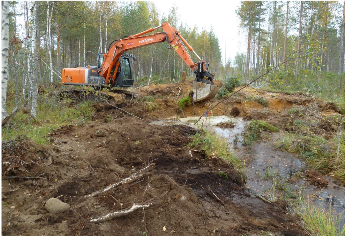
Kuva 5-3 Ojitetun suon ennallistamista kaivinkonetyönä. Kuva: Sari Kaartinen.
