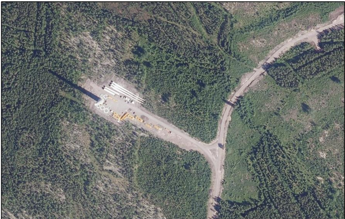
Kuva 7.3. Esimerkkikuva rakennusvaiheessa olevan tuulivoimalan pystytys- ja työskentelyalueesta.
