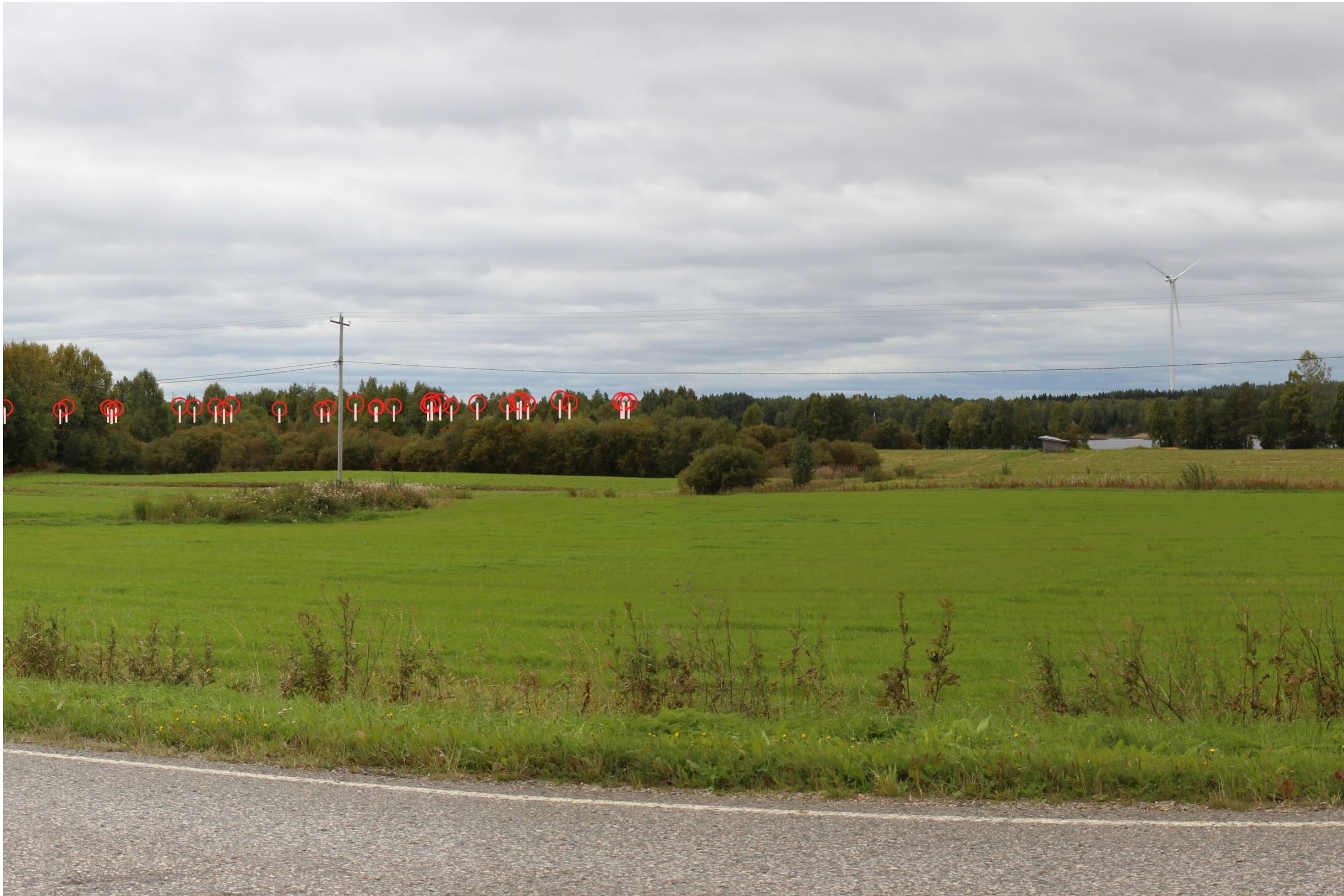
Kuva 8.4. Ihmiskatsetta (vaakatasossa 40 asteen kuvakulmaa) vastaava leike havainnekuvarasta. Kuvassa on korostettu voimaloiden tornit valkoisilla viivoilla ja lapojen pyörimisalueet punaisilla ympyröillä.
