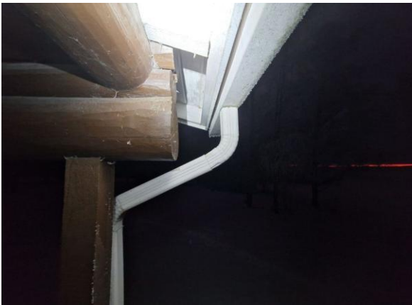
Kuva 16. Päämökissä räystäskourut ja syöksytorvet.
