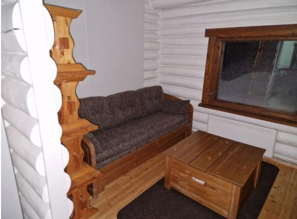
Kuva 49. Väliseinät osin hirsi ja osin levyrakenteisia.
