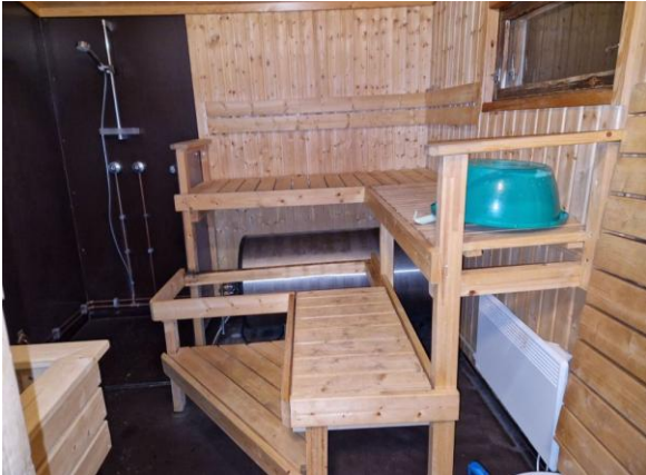
Kuva 64. Saunan tilapinnat osin paneloituja/levytyistä. Tilapinnat siistit.
