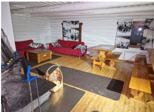
Kuva 50. Oleskelutilat olivat siistikuntoiset. Seinät maalattu lähivuosina, lattia on puulattiaa, jossa on paikoin kulumisen jälkiä.
