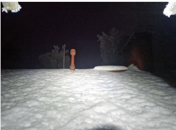
Kuva 47. Päärakennuksen vesikattoa ei lumen ja jään vuoksi pystytty tarkastamaan. Vesikatolla piippu, vesikattoluukku sekä viemäri tuuletusputki.
