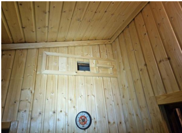
Kuva 87. Saunatilän tuuletusräppänä.
