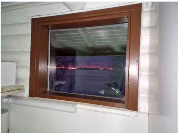
Kuva 37. Keittiöön vaihdettu ikkuna keittiö remontin yhteydessä. Ikkuna on hyväkuntoinen.
