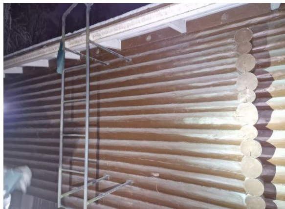
Kuva 28. Rakennuksen takaosan julkisivujen pinnat ovat siistikuntoiset.
