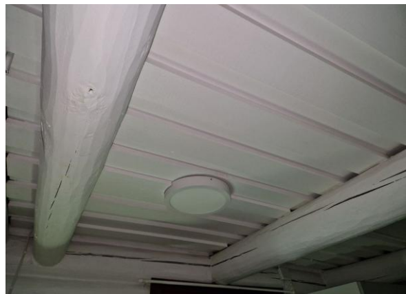
Kuva 26. Sisäpuolelta tarkasteltuina hirret olivat hyväkuntoisia.
