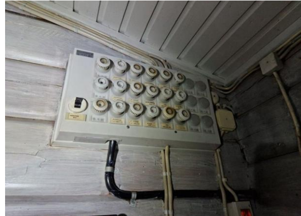
Kuva 94. Saunamökin vanhempi keskus (arviolta 80-luvulta).
