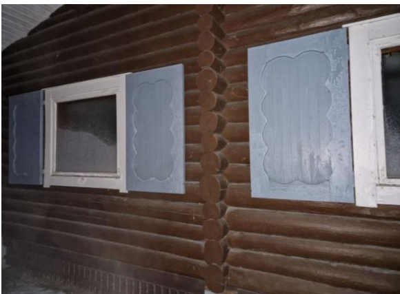
Kuva 25. Rakennuksen kantavissa hirsirakenteissa ei päällisin puolin havaittu merkkejä vaurioista.
