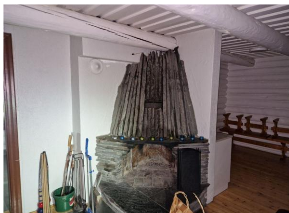
Kuva 61. Päämökin takka. Takka on päällisin puolin siistissä kunnossa.
