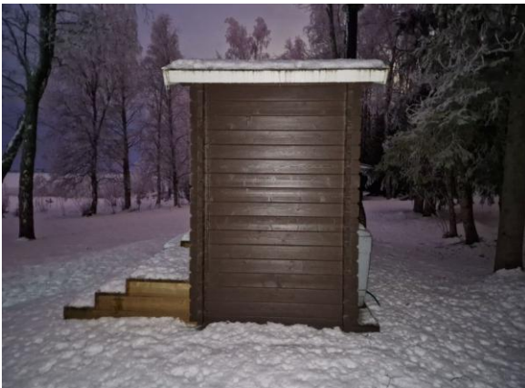
Kuva 12. Ulkokäymälöiden pinnat siistissä kunnossa.
