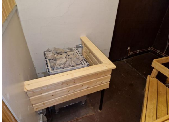
Kuva 65. Kiuas seinällä piippu muurattu ja pintakäsitelty ja osin sivustalla levytys.
