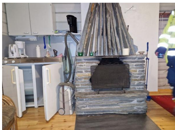
Kuva 59. Takka oli päällisin puolin siistissä kunnossa. Takan edellisestä käyttökerrasta ei ole tietoa, tilassa sähkölämmitys.
