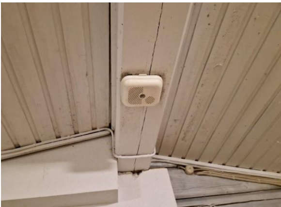
Kuva 116. Palovaroitin saunarakennuksessa.
