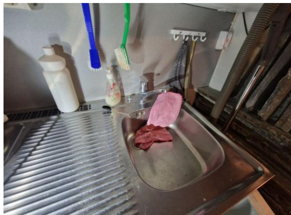
Kuva 85. Saunan pesualtaan hana.
