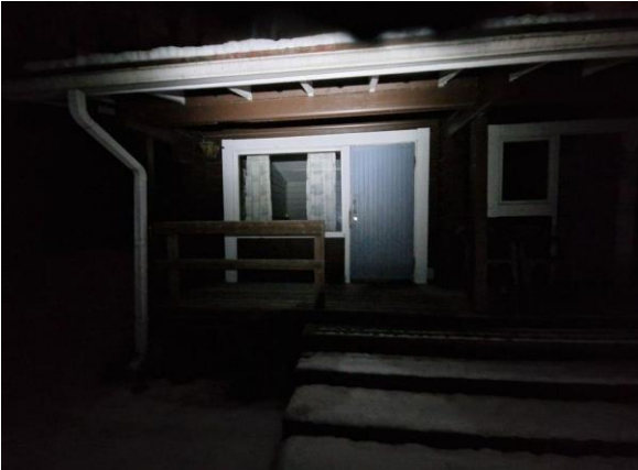
Kuva 20. Saunamökissä veden poisto tapahtuu syöksytovista maaperään, myös saunamökin vedenpoistoa kauemmas rakennuksesta suositellaan parantamaan.
