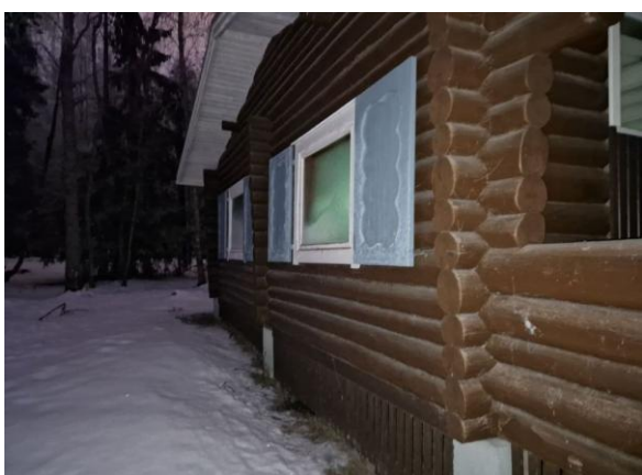
Kuva 31. Alaosa julkisivusta verhoiltu rimoilla.
