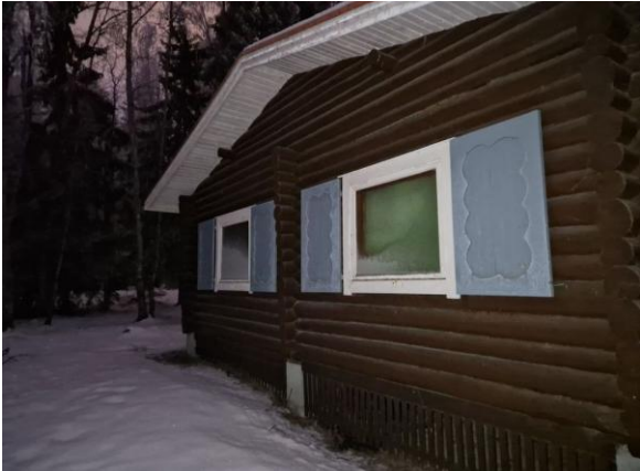
Kuva 35. Päämökkin ikkunat ovat alkuperäiset rakennusvuodeltaan.
