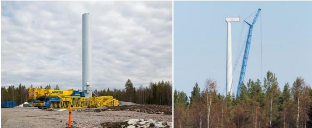
Kuva 22. Tuulivoimalan kokoamista. (Kuvat: FCG)
