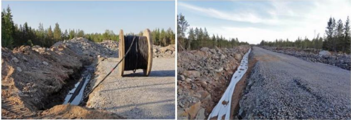
Kuva 20. Maakaapelit upotetaan huoltoteiden yhteyteen (kuvat: FCG).
