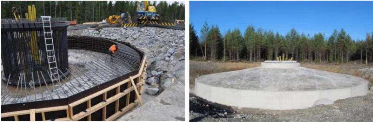
Kuva 21. Tuulivoimalan perustusten rakentamista. (Kuvat: FCG)
