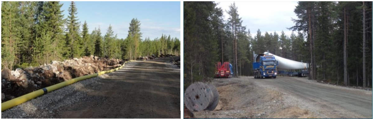
Kuva 17. (Vasemmalla) Esimerkki tuulivoimapuiston rakennus- ja huoltotiestä. Teitä käytetään muun muassa betonin, soran ja voimaloiden komponenttien kuljetuksiin sekä tuulivoimapuiston käyttöväheessä huoltoajoihin. Maakaapeli sijoitetaan ojakaivantoon tien reuna-alueelle. (Oikealla) Tuulivoimalan osia kuljetetaan erikoiskuljetuksina. (Kuvat: FCG).
