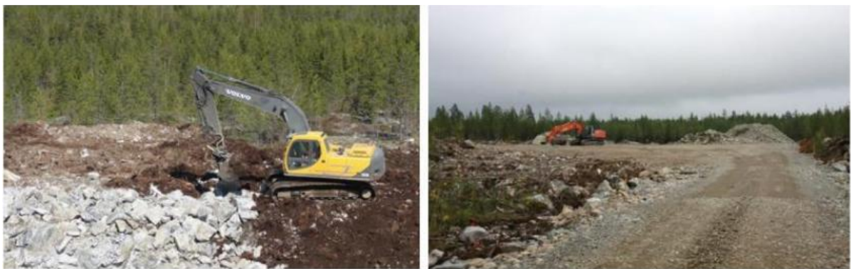
Kuva 19. Tuulivoimapuiston rakentaminen alkaa huoltoteiden ja pystytysalueiden
