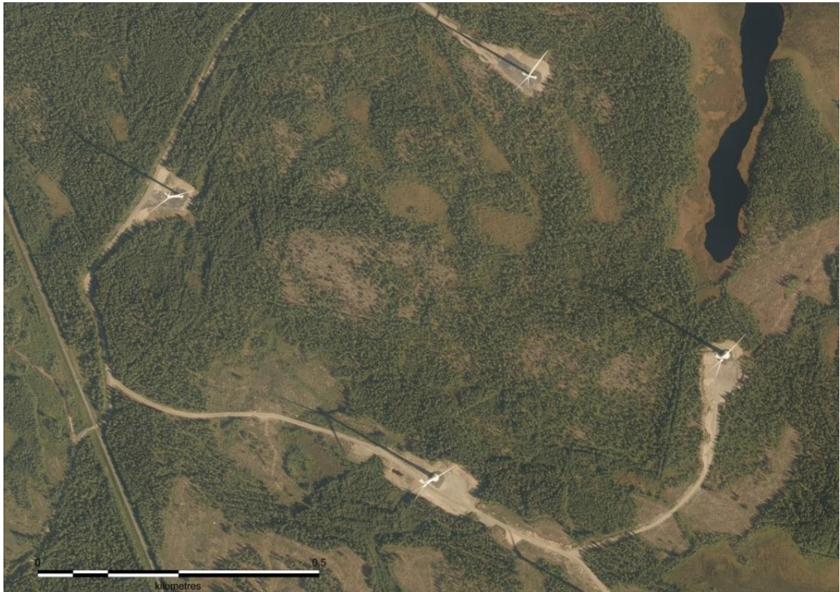
Kuva 10. Ilmakuvassa näkyy toiminnassa olevia tuulivoimaloita. Tuulivoimaloita varten on rakennettu huoltotiet ja nostokentät. Tuulivoimaloiden ympäristössä ja välialueilla aikaisempi maankäyttö on säilynyt ennallaan.
