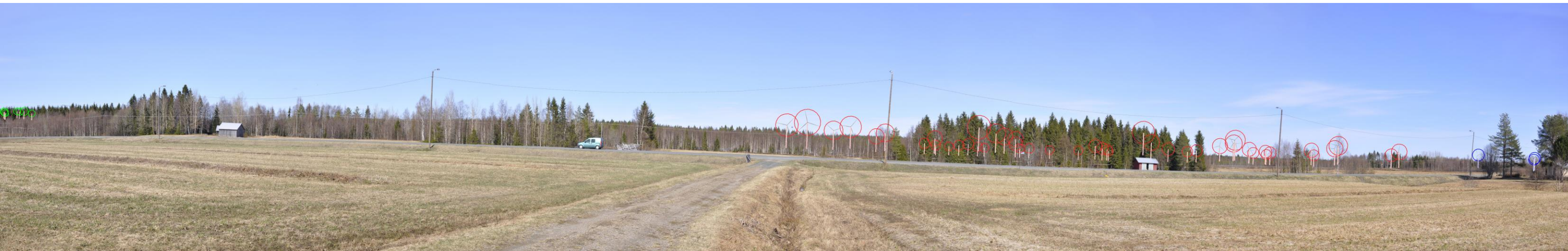
Kuva 40. Valokuviasovite kuvauspisteestä 7 on otettu Niemenpäästä, Torniossa. Etäisyys lähimpiin Karhakkamaan voimaloihin on noin 5,0 kilometriä. Karhakkamaan voimaloiden roottoriympyrä korostettu punaisella. Kitkiäisvaaran toiminnassa olevat voimalat on korostettu sinisellä ja Reväsvaaran kaavoitetut voimalat vihreällä.
