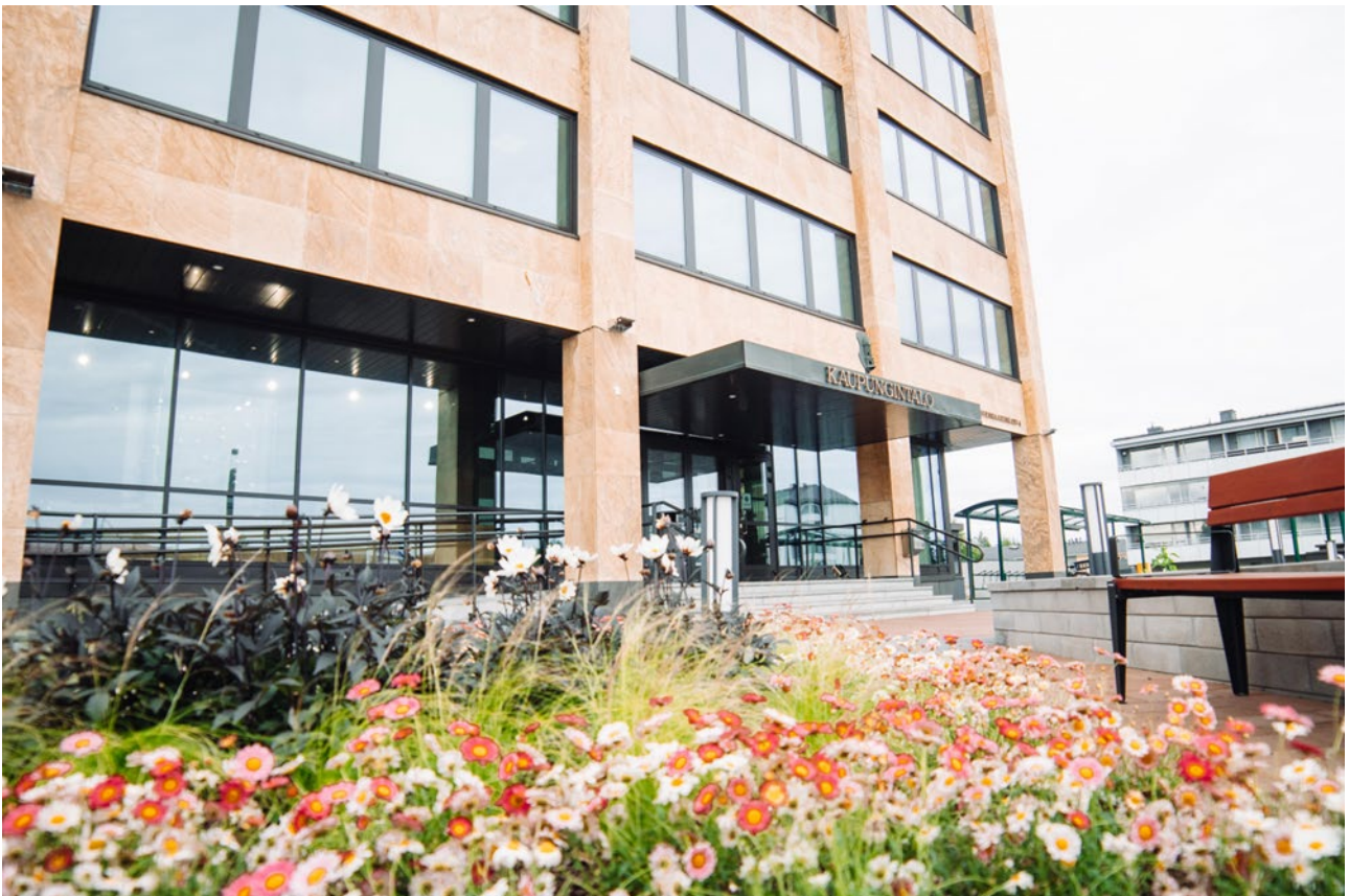
Kuva: Tornion kaupunki
