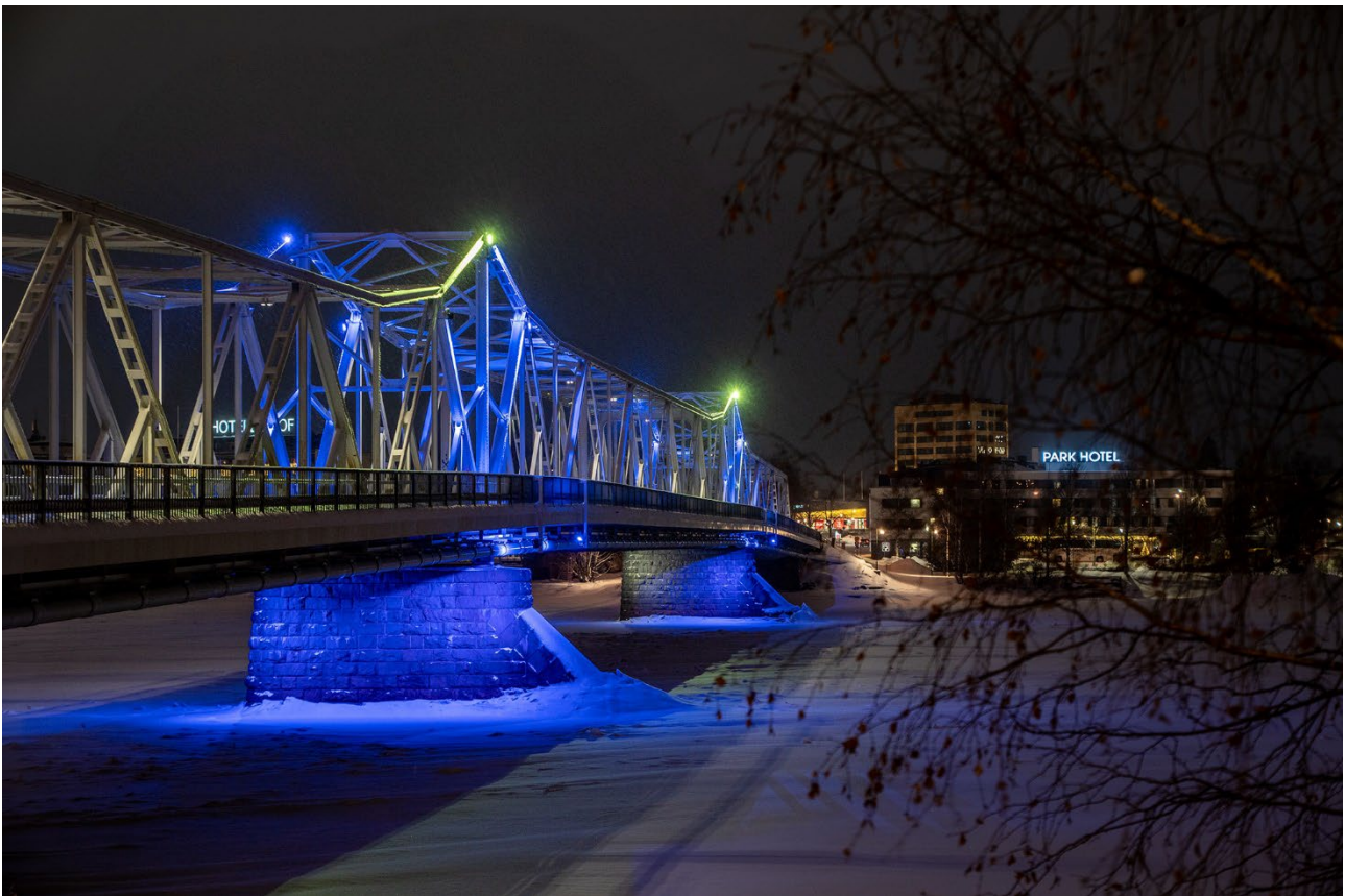
Kuva: Tornion kaupunki
