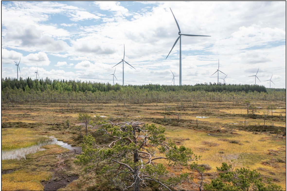
Kuva 7.2 Esimerkkikuva tuulivoimaloista (Kuva: Myrsky Energia Oy / Ville Suorsa)
