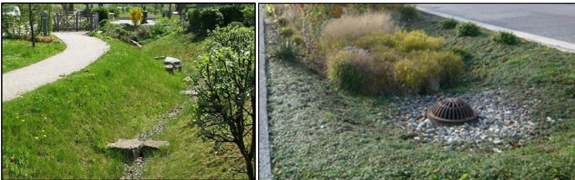
Kuva 15. Vasen kuva: Esimerkki hulevesien pintajohtamista kadun reunaosassa, johon on istutettu kasvillisuutta ja rakennettu pohjapatvoja. 4 Oikea kuva: Esimerkki katualueen viherpainanteesta, jossa on ylivuotojärjestelmä hulevesiviemäriverkkoon (Seattle, USA). 4
