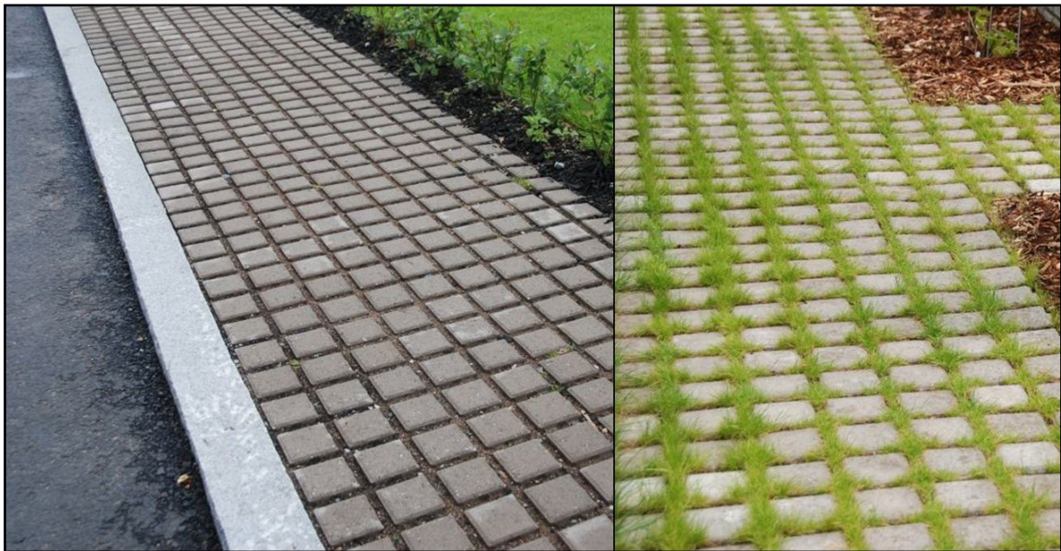
Kuva 12. Esimerkkejä läpäisevien päällysteiden käytöstä. 4
