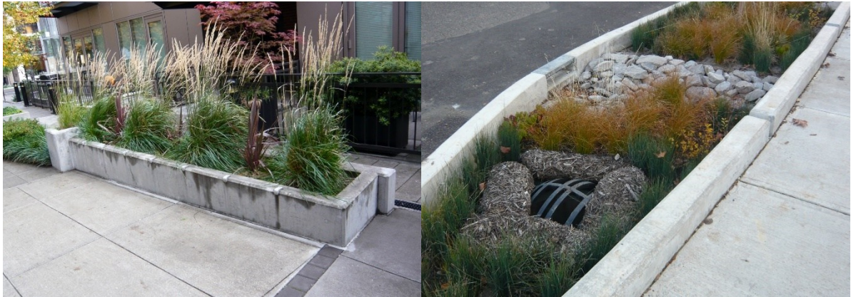
Kuva 10. Tyypikuva kattovesien viivytys-/imeytysjärjestelmästä. 4
