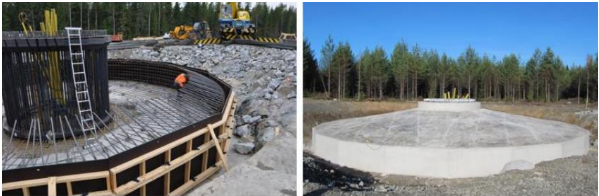
Kuva 21. Tuulivoimalan perustusten rakentamista. (Kuvat: FCG)
