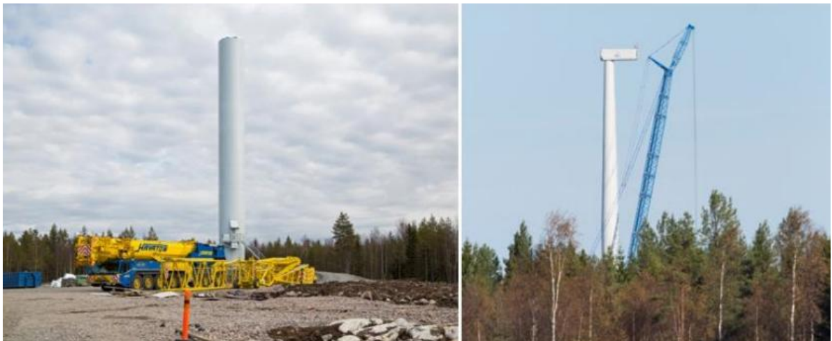
Kuva 22. Tuulivoimalan kokoamista. (Kuvat: FCG)
