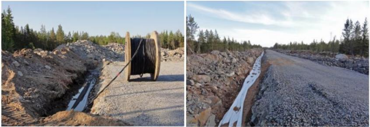
Kuva 20. Maakaapelit upotetaan huoltoteiden yhteyteen (kuvat: FCG).
