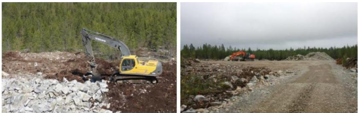
Kuva 19. Tuulivoimapuiston rakentaminen alkaa huoltoteiden ja pystytysalueiden
