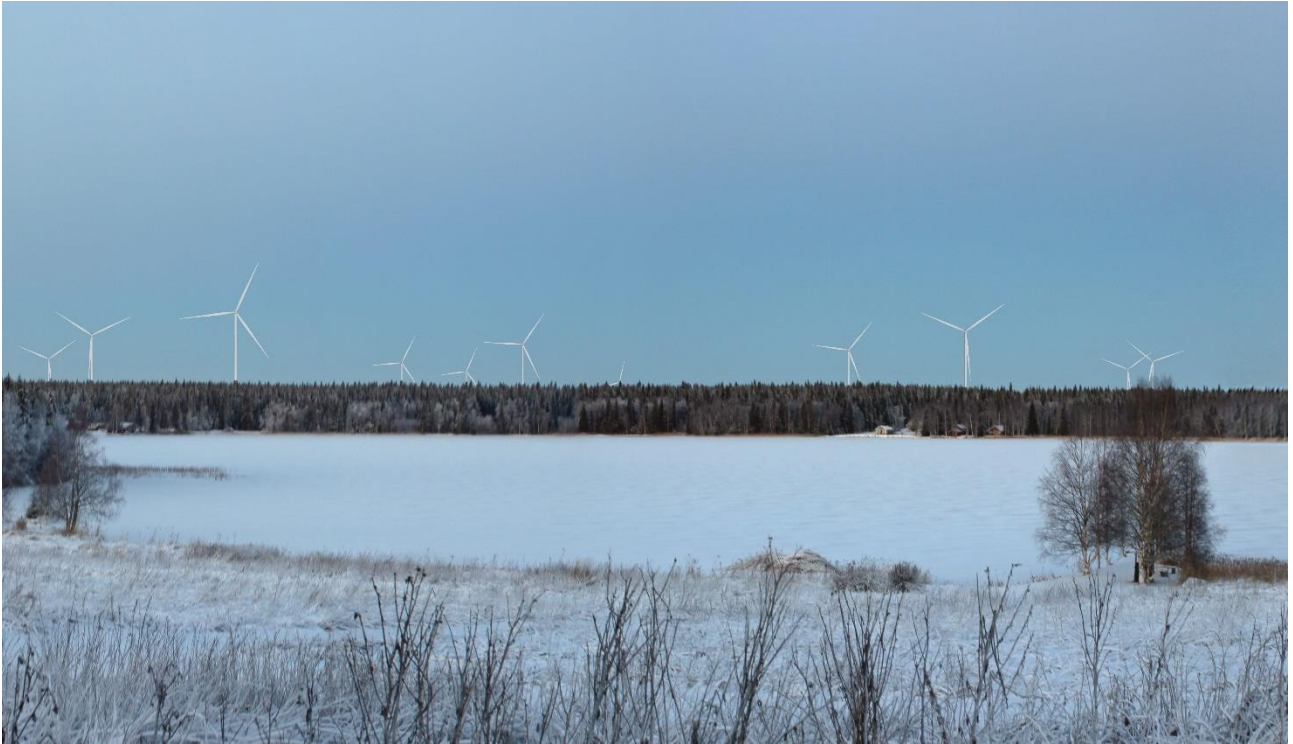
Kuva 10.16. Havainnekuva Korpijärveltä. Kuvakulma vastaa kinofilmikoon 50 mm objektiivin kuvakulmaa. Voimalat näkyvät hallitsevina maisemassa. Voimaloista viisi oikealta ovat Kuoringin voimaloita. Kuvauspisteestä hankkeella on merkittäviä vaikutuksia maisemaan.
