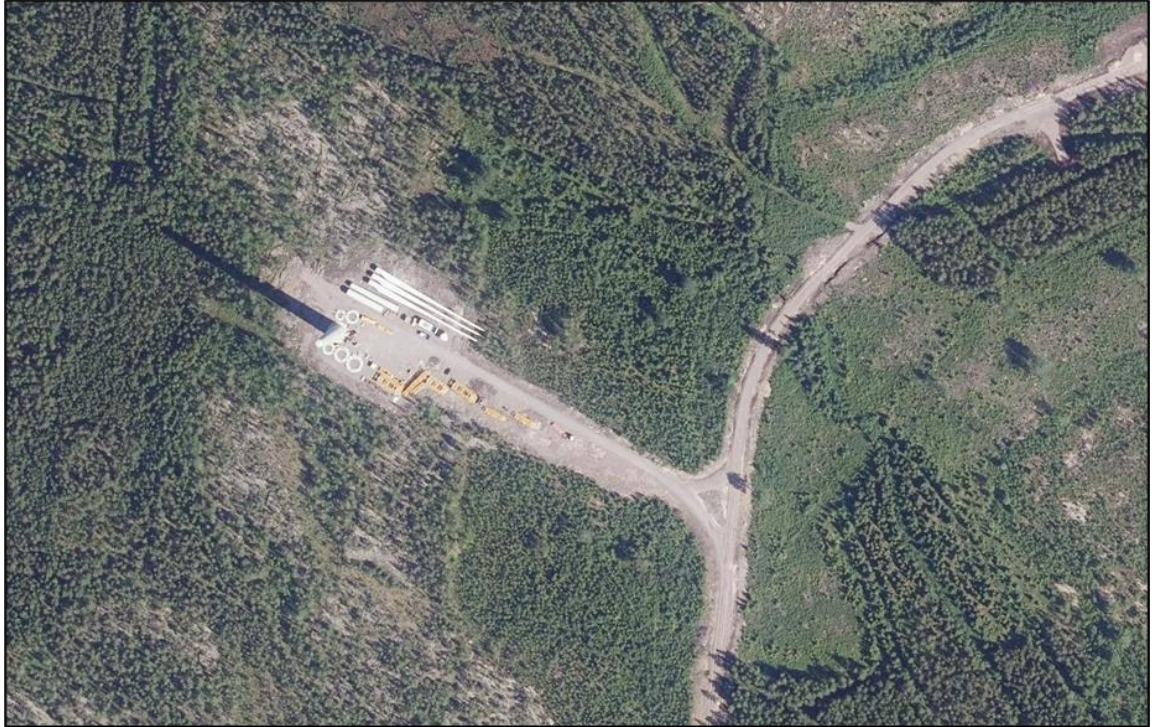
Kuva 7.4. Esimerkkivalokuva rakennusvaiheessa olevan tuulivoimalan pystytys- ja työskentelyalueesta.
