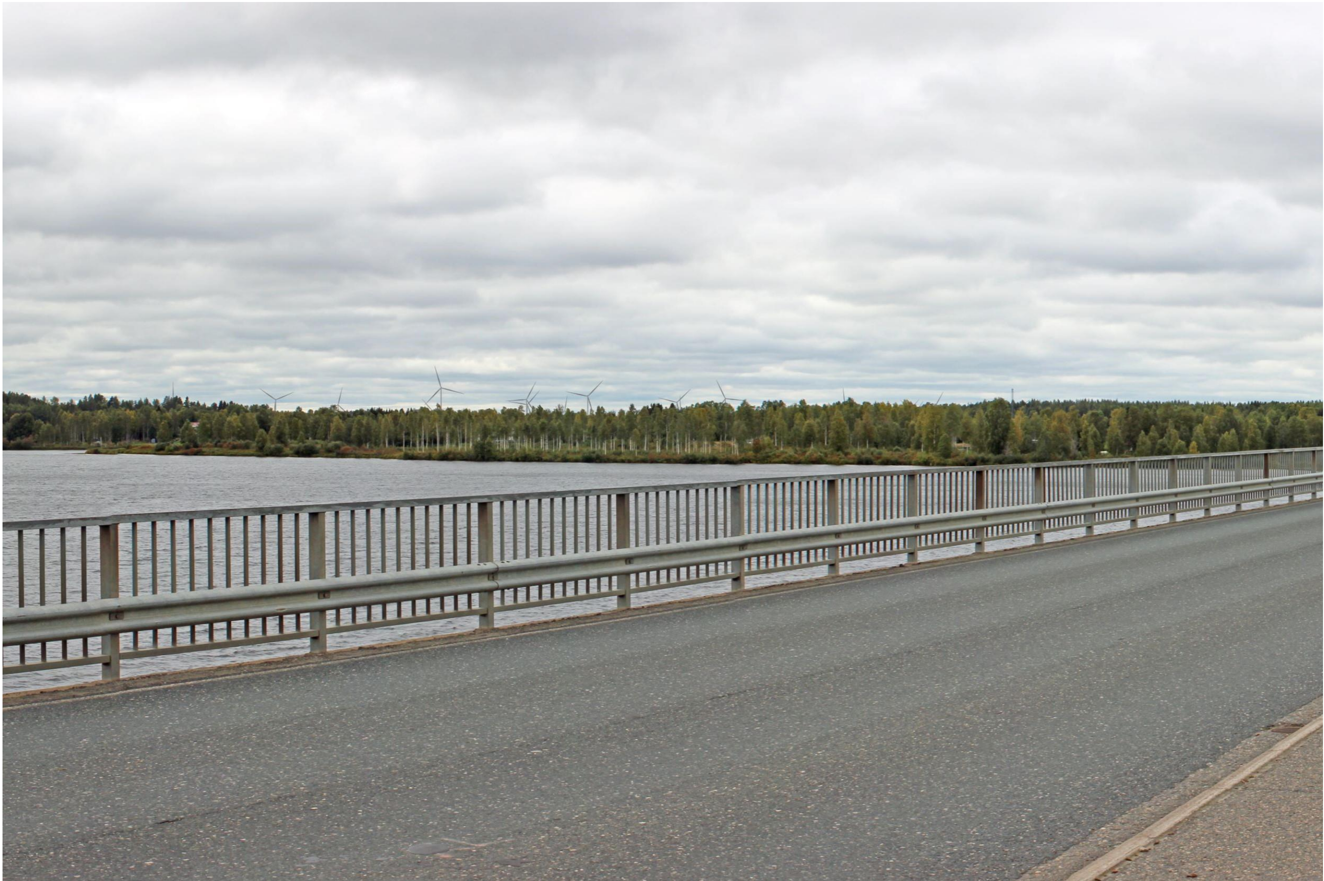
Kuva 8.2 Havainnekuva Tervolasta. Kuvakulma vastaa kinofilmikoon 50 mm objektiivin kuvakulmaa. Voimalat näkyvät maisemassa. Kuvauspisteestä merkittävin maisemallinen elementti on silta, jonka takaa voimalat näkyvät. Kuvauspisteestä hankkeella on kohtalaisia vaikutuksia.
